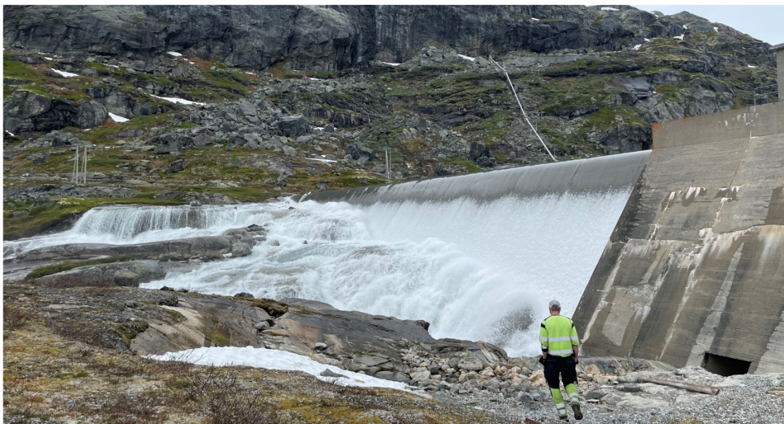
Dam Fivlemyr overløp
