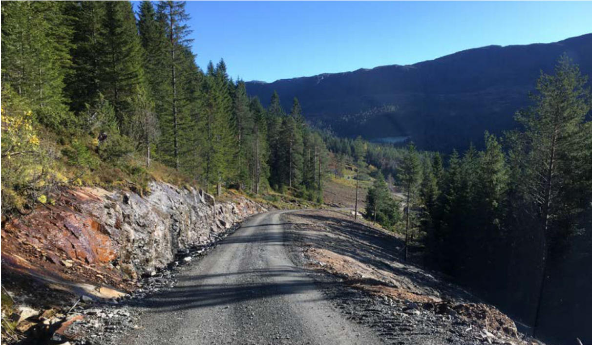
Figur 3-17 Prinsipp for arrondering av vei.
