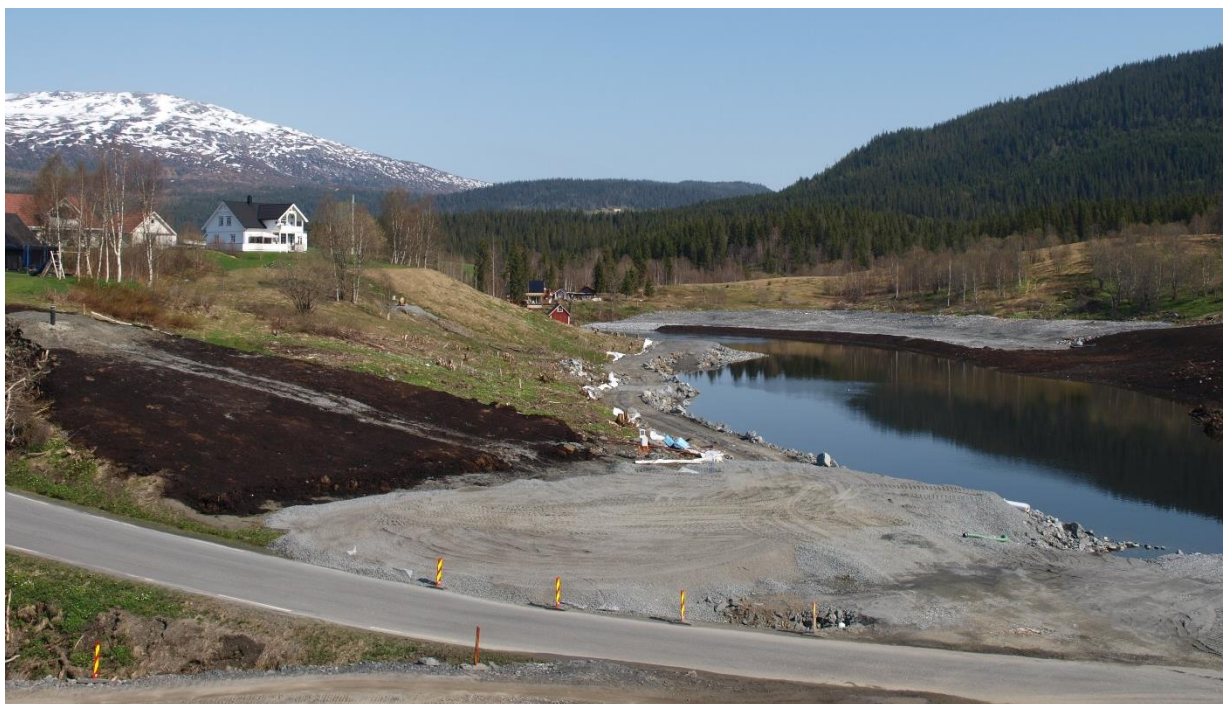
Figur: Oversikt erosjonssikring samt flate tilrettelagt for installasjon av kalk-sement. 15.5.2018
