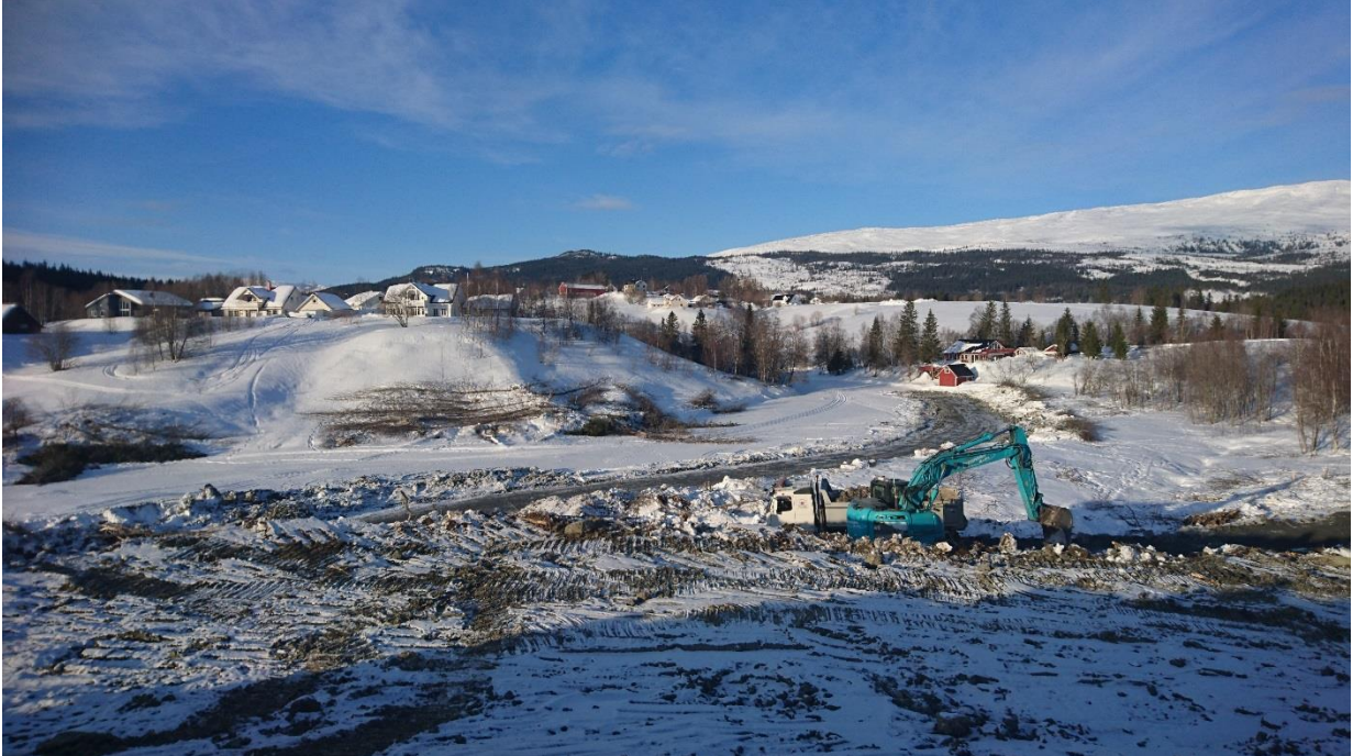
Figur: Oversikt før arbeider med erosjonssikring, etter trær er tatt ned. 13.2.2018
