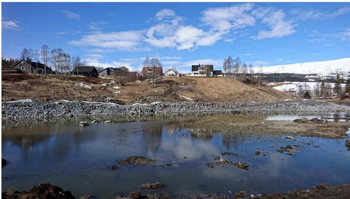
Figur: Oversikt over arbeidet med erosjonssikringen delvis ferdigstilt. 2.5.2018
