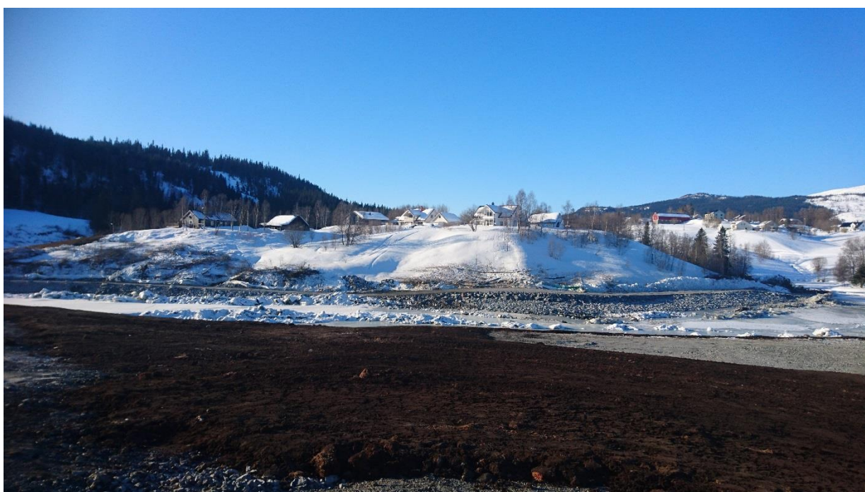
Figur: Oversikt over arbeidet med erosjonssikringen delvis ferdigstilt. 7.3.2018
