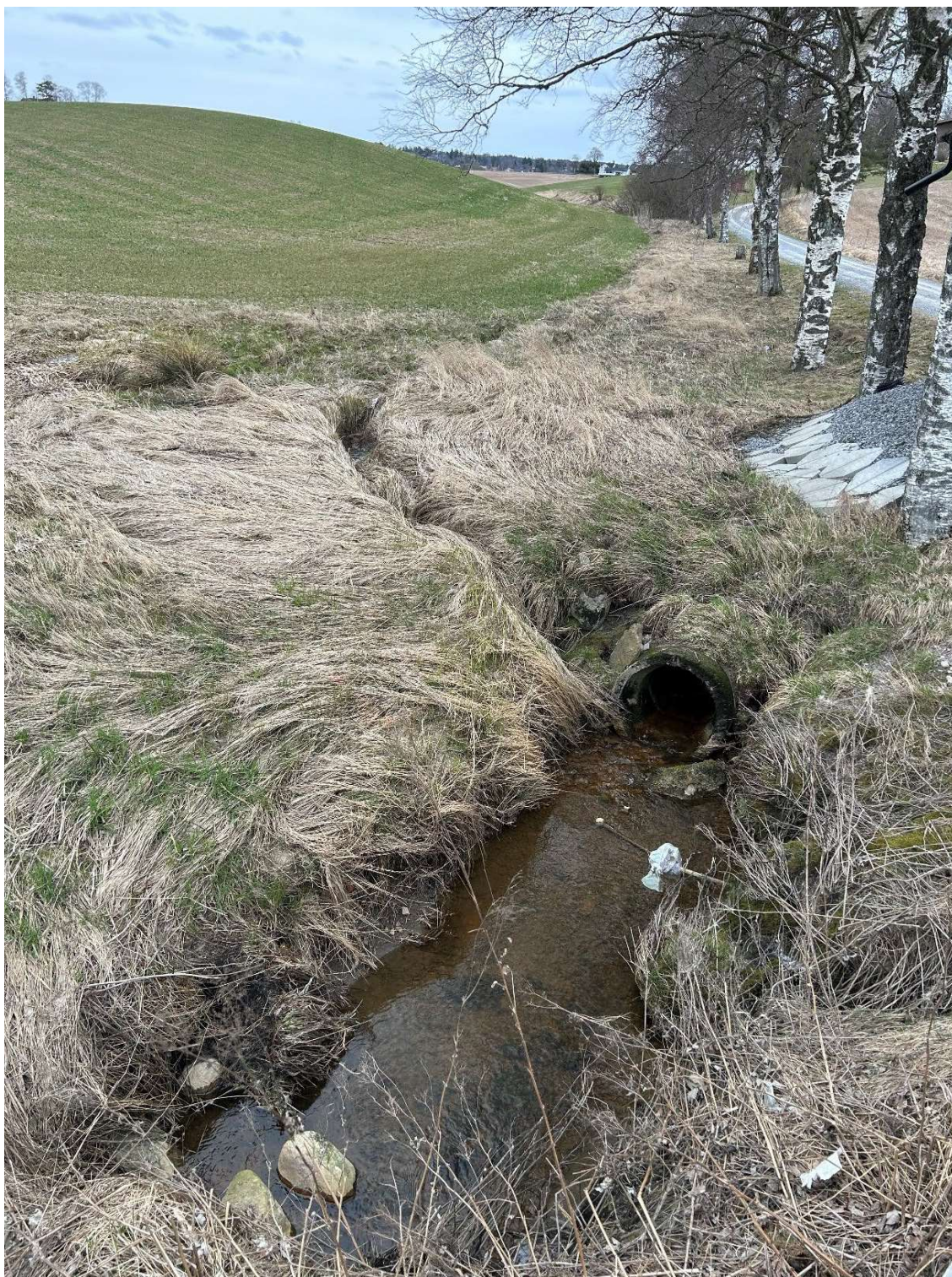
Figur 10 – Stikkrennas utløp på østsida av Rv. 22 ses så vidt til venstre. Vegen i bakgrunnen er gårdsvegen til Sarpsborgveien 152. Røret midt i bildet er innløp til bekken nedstrøms Rv. 22.
