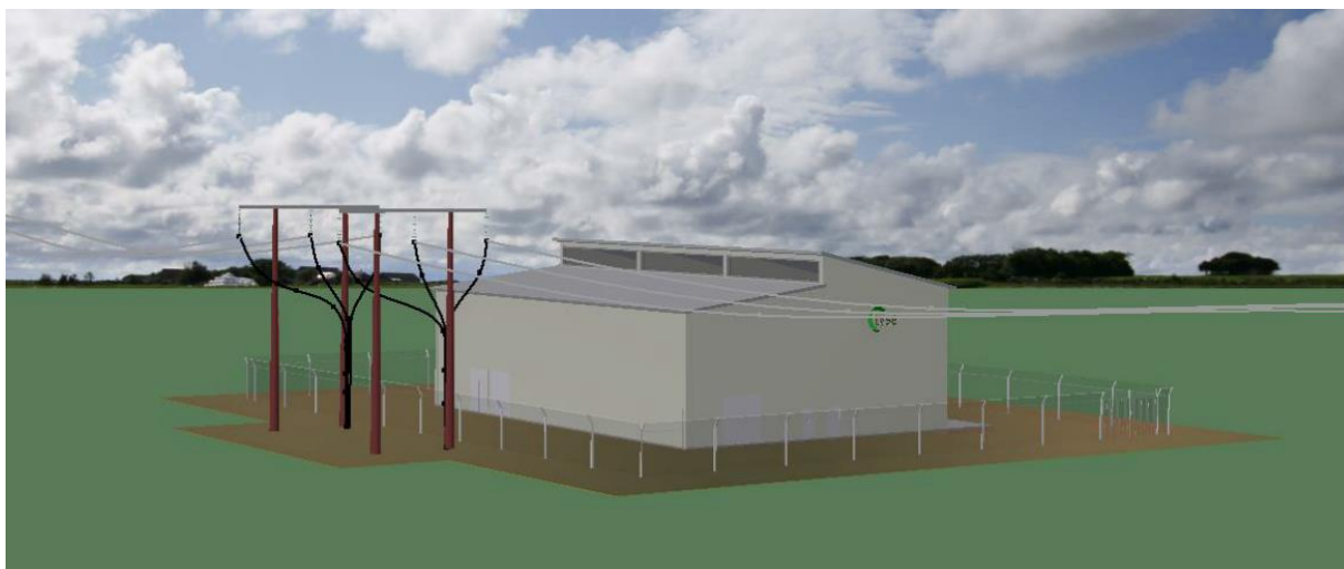
Figur 4: Illustrasjon av et GIS-anlegg med innendørs bryteranlegg.
