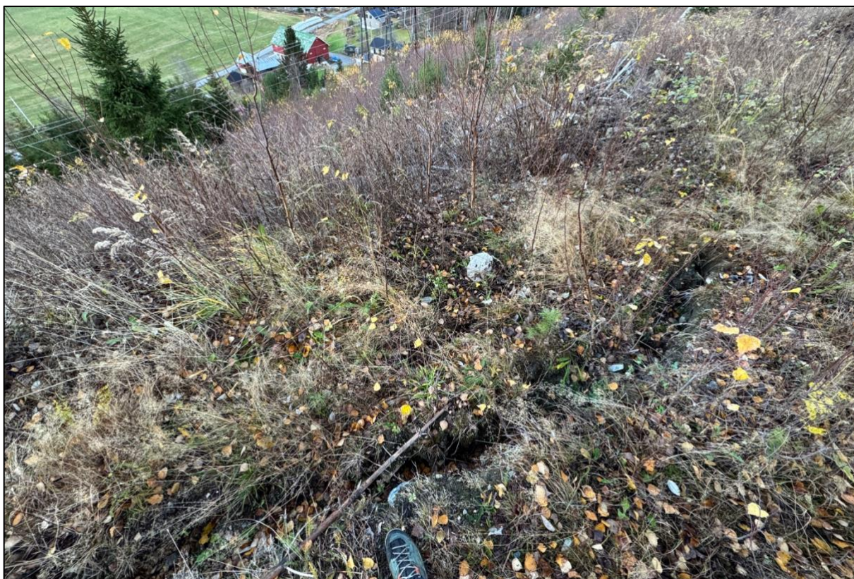
Figur 18: Sprekk i en skogsveg over bebyggelsen ved Lauvsletten. Vi tolker at den påbegynte utglidningen trolig har skjedd under ekstremværet Hans.
