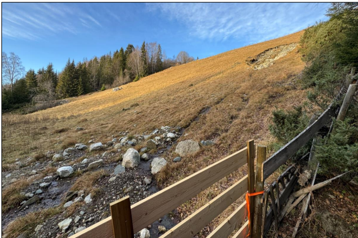
Figur 14: Bilde som viser løsneområdet til en skredhendelse som gikk under ekstremværet Hans ved Sveinsrud, sett mot nordvest (2023-08-08C). Neste bilde er tatt rett nedenfor.
