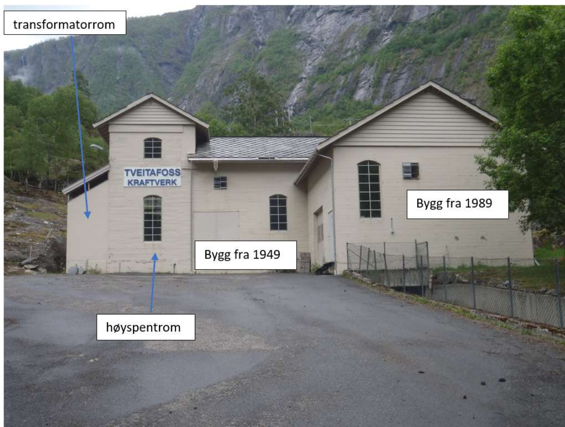
Figur 19. Bilde av kraftstasjonsbygg.
