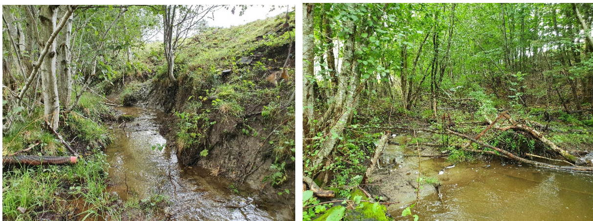
Figur 8: Erosjon i sand/silt langs Setnesgrova nedenfor terrengprofil Æ-Æ og Ø-Ø
