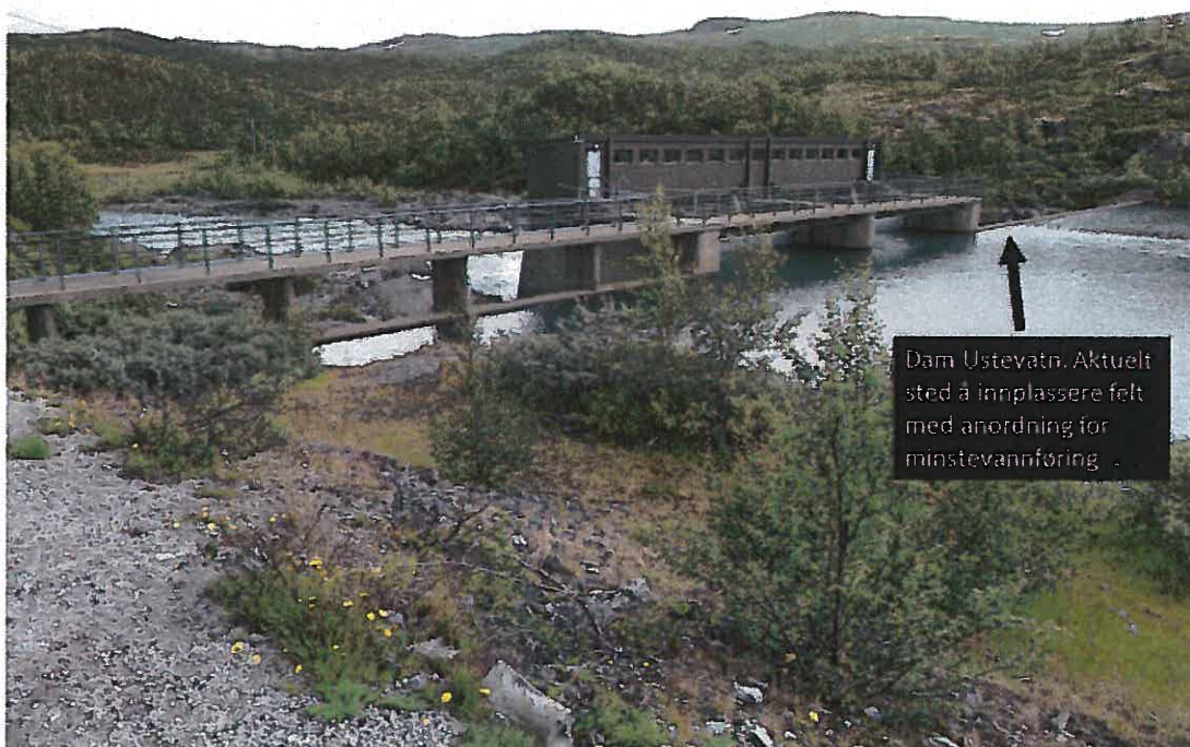
Bilde: Vannstanden må minst være på kote 982,3 for at det skal være mulig å etablere en anordning for minstevannføring ved Dam Ustevatn.
