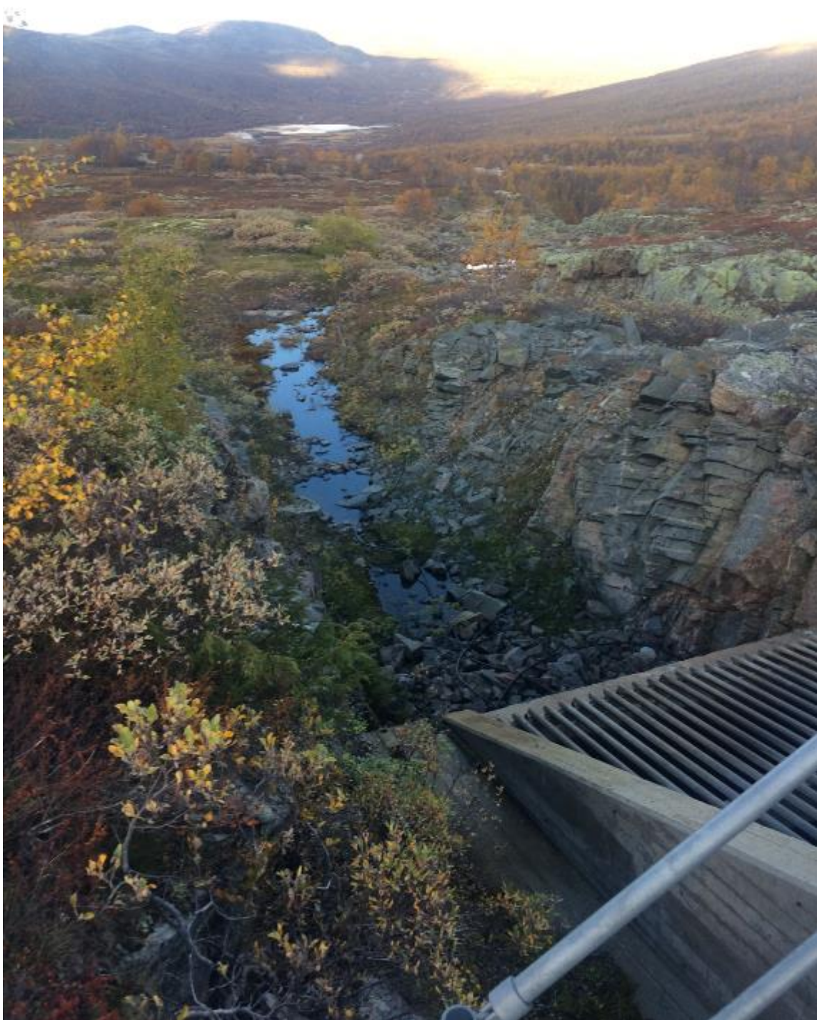
Figur 7. Bekkeinntak Krukeåi. Sett nedover mot Solheimstulen. Foto: Anne Karine Herland, NVE.
