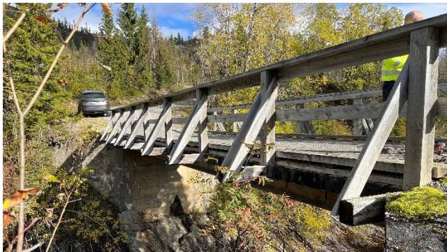
Figur 3-6. Bro som vil kreve tiltak før anleggstrafikk.
