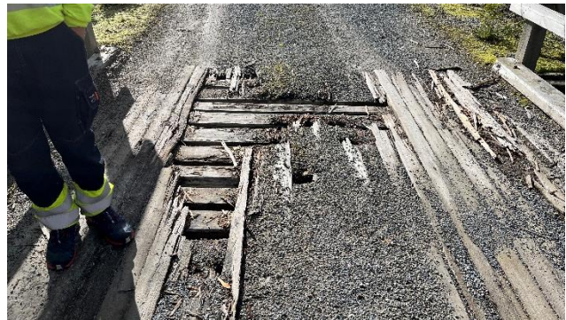
Figur 3-7. Tilstand på bro som krever tiltak.
