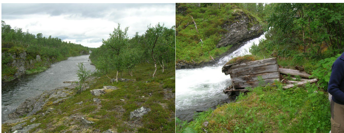
Fig.2: Venstre: Fra inntaksområdet. Høyre: Rester av gammel kraftverksbygning ca. midtveis på fallstrekningen. (Foto: Småkraftkonsult 2022)
