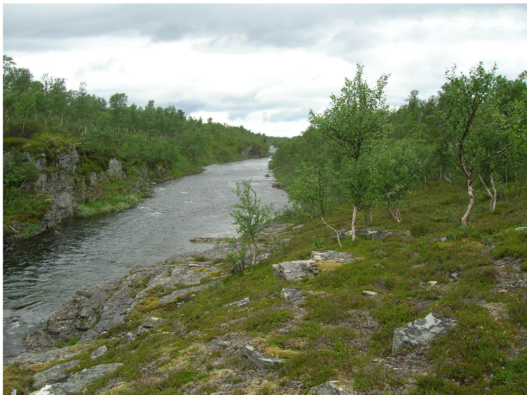
Grøna oppstrøms inntaksdam mot Grønsjøen (Foto: Småkraftkonsult).
