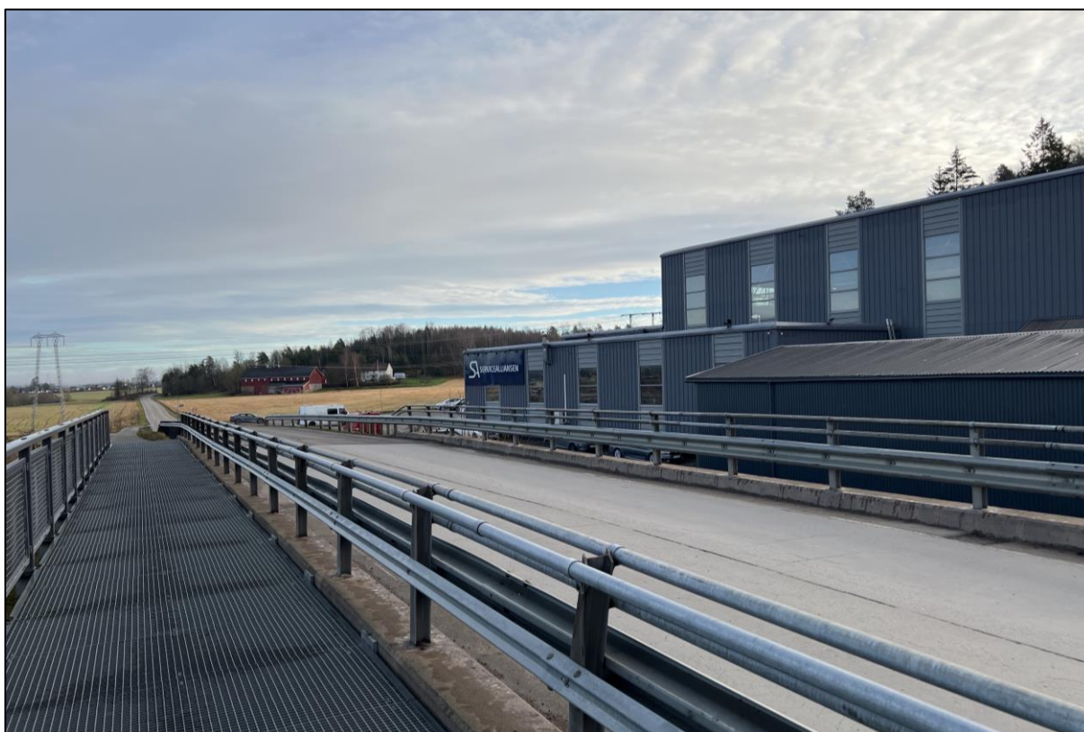
Figur 5-10: Askehaug gård sett fra brua over E18. Det er allerede mye infrastruktur i området hvor nye Askehaug transformatorstasjon vil ligge, som er til høyre i bildet.
