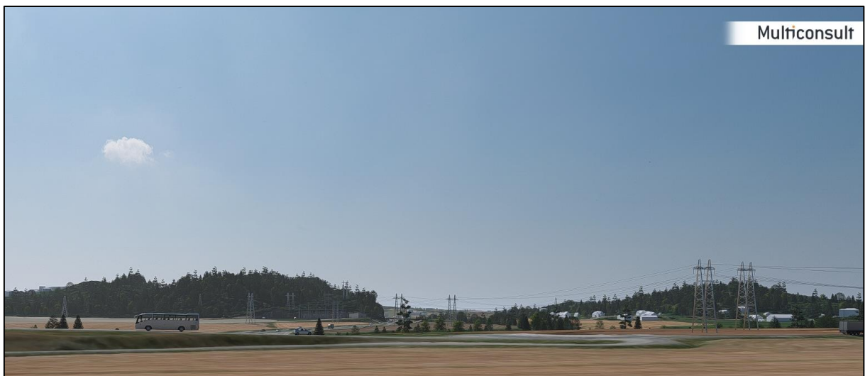
Figur 5-14: Visualisering av alternativ 1 sett fra Mellem Hesby mot stasjonsområdet. Ledningstraseen kommer nærmere og følger ikke lenger retningen i landskapet fra Kjerringhøvet og sørover. Den nye ledningstraseen ligger nord for Merkedamselva og dempes ikke av kantvegetasjonen langs denne. Sett fra delområdet vil den nye ledningstraseen sees tydelig i daldraget mellom de to kollene øst og vest for E18. Dette vil påvirke landskapsopplevelsen negativt.
