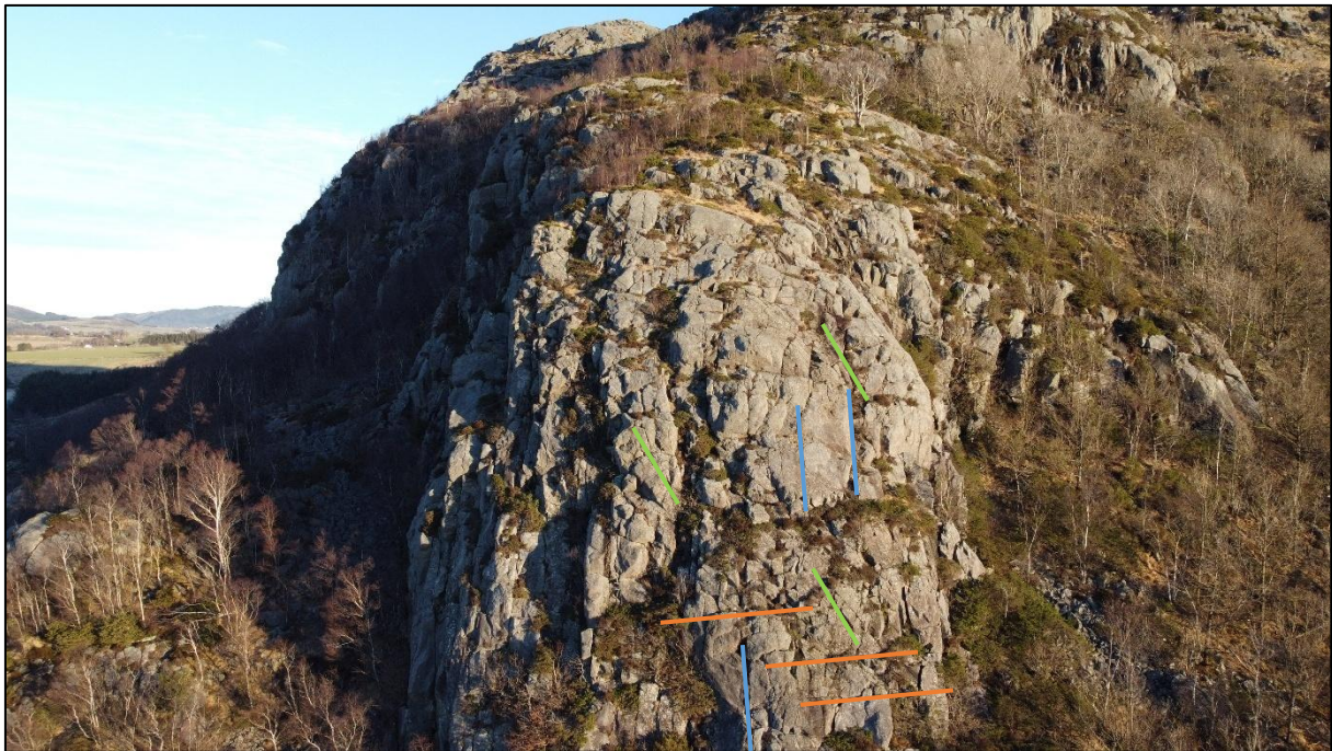
Figur 5: Bildet viser bergskrent i påvirkningsområdet, med omtrentlig inntegnet de tre mest fremtredende sprekkesett. Bildet er tatt med drone mot nordøst, og viser skrenten ca. 160-180 moh. i vestlige del av påvirkningsområdet.
