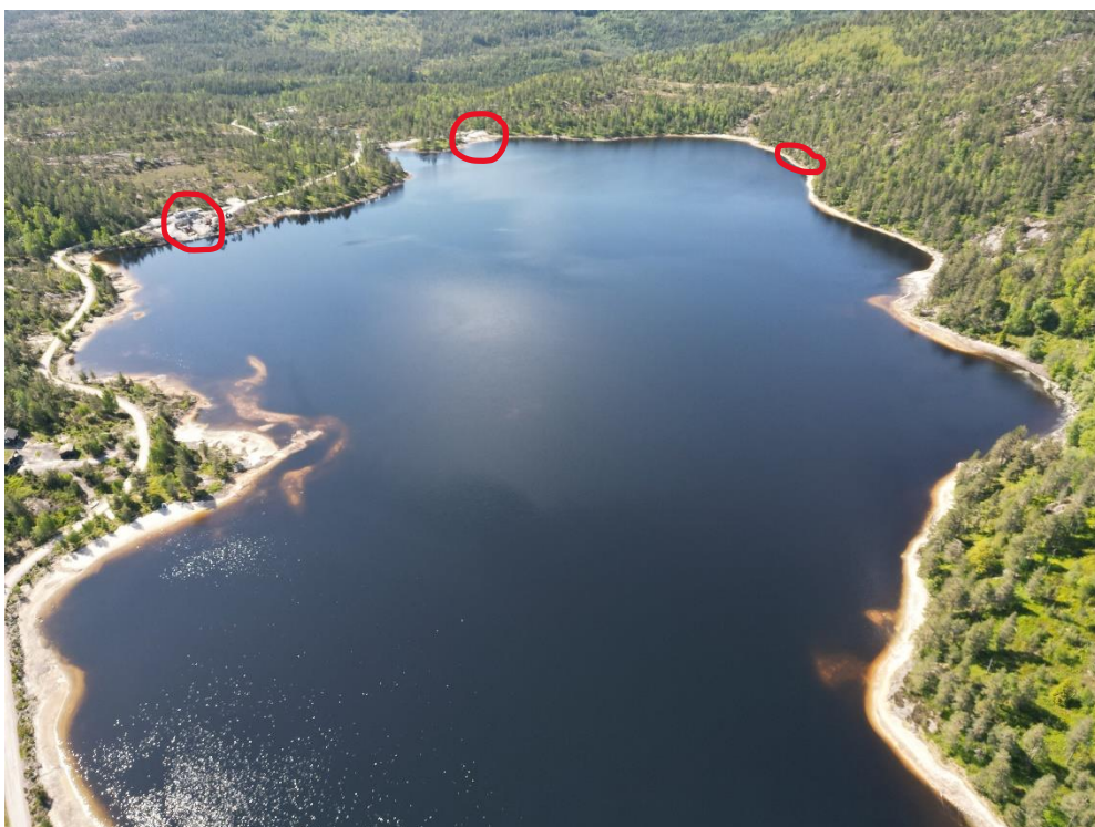
Kjetevatn mot sør. Inntak topp venstre, dam topp midt og planlagt utløp overføringstunnel topp høyre. Vannstand LRV.
