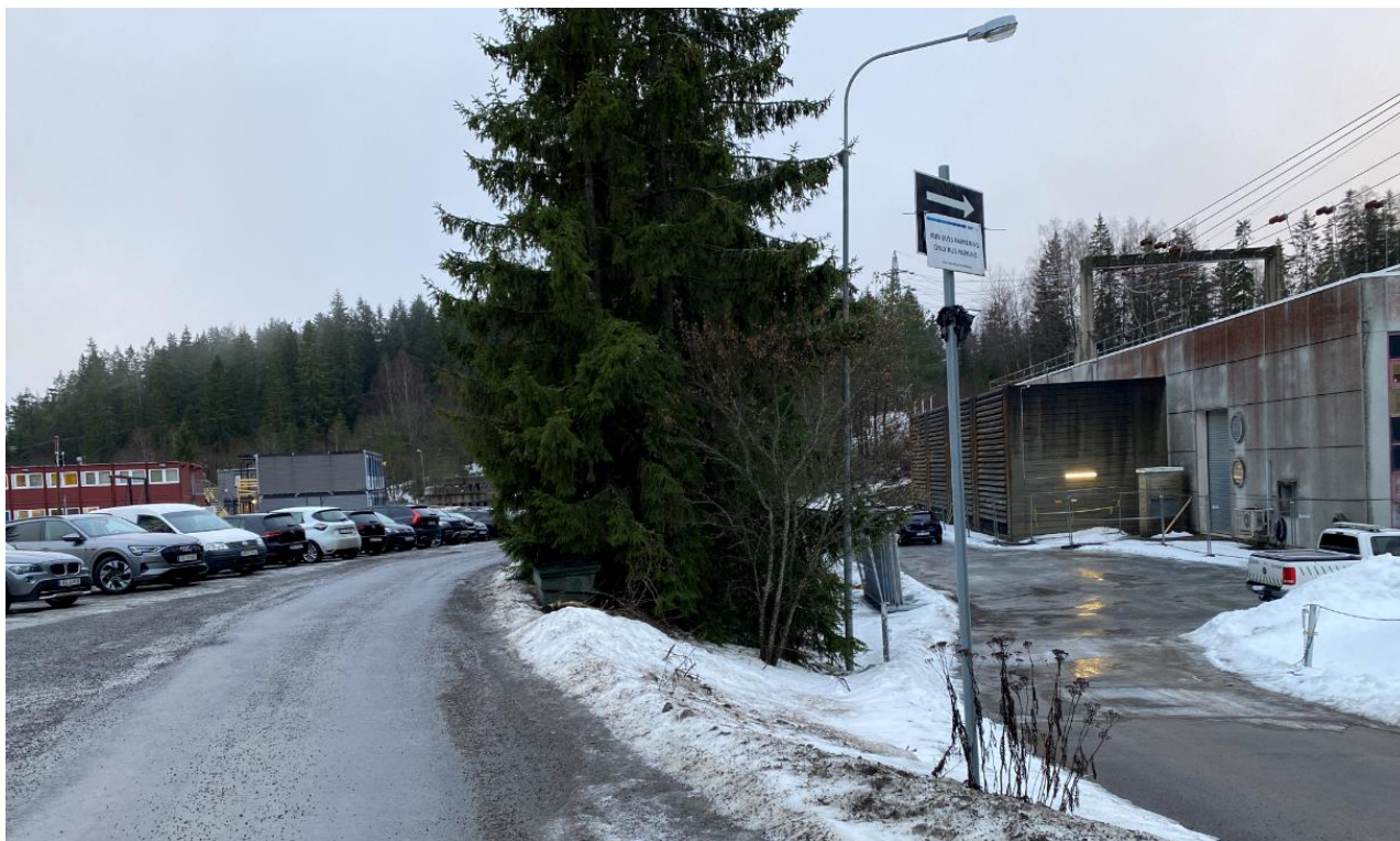
Figur 5-5: dagens Klemetsrud transformatorstasjon sett fra øst.
