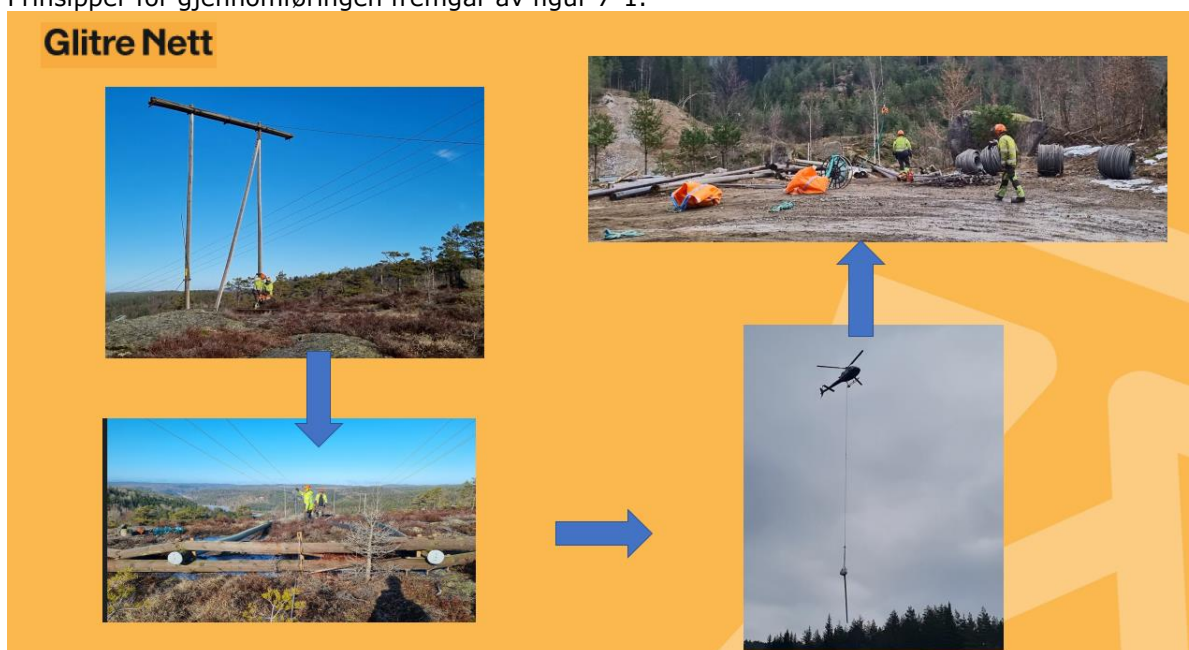
Figur 7-1 - Flytskjema for gjennomføring av rivingen.
