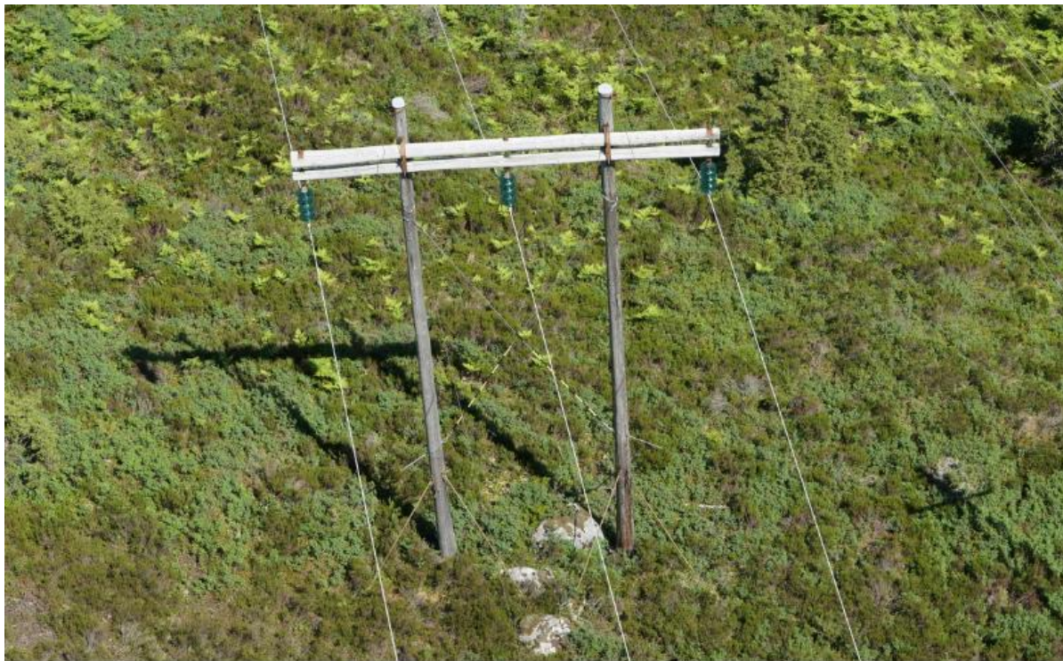
Figur 6-2 - Dronebilde av mast på strekningen mellom Finså og Oftedal som skal rives.
