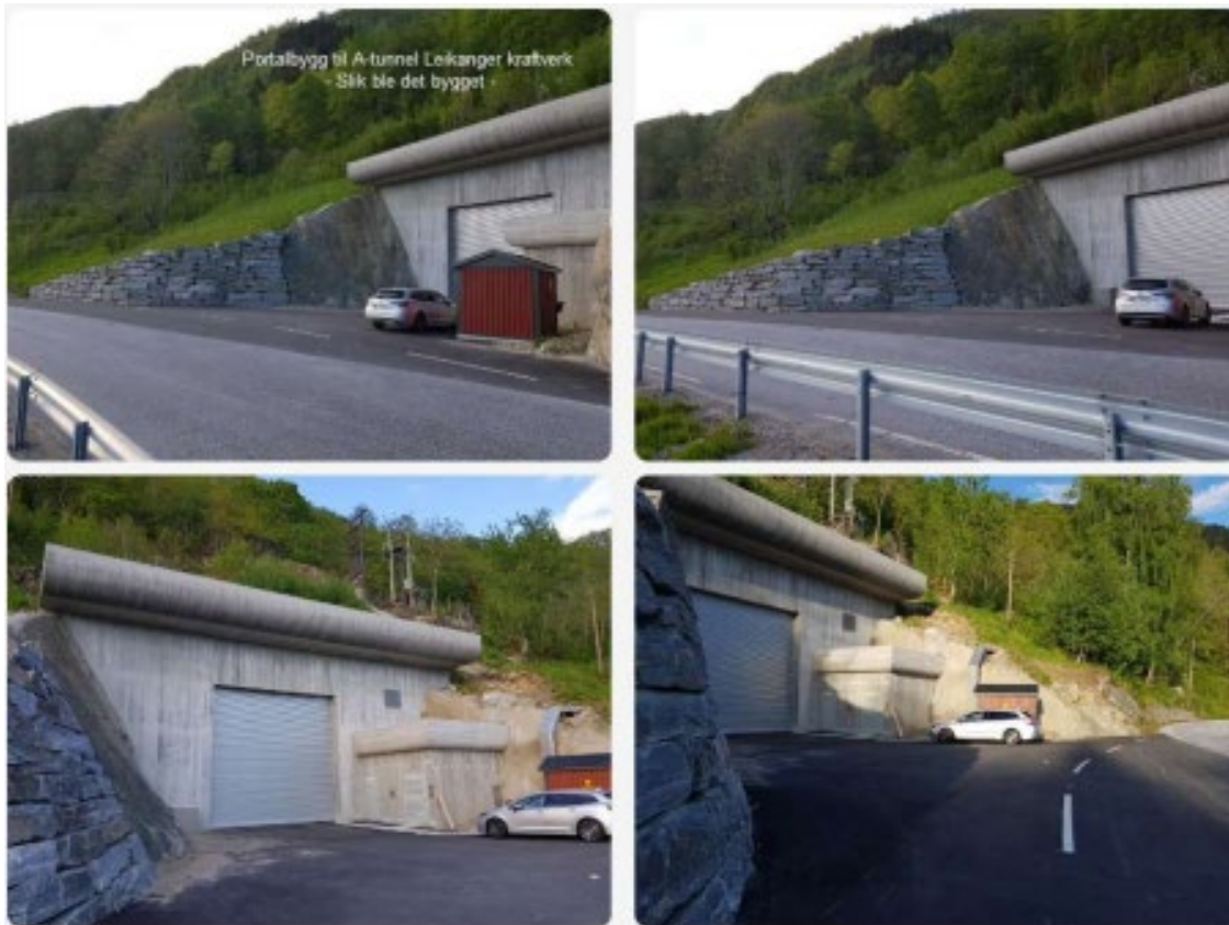
Figur 7: Portalbygget for Leikanger kraftverk i Sogndal kommune (foto: Norconsult). Portalbygget og utearealer for Hemsil 3 kraftverk vil ha om lag tilsvarende utforming.
