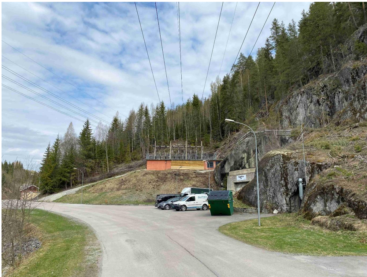
Figur 12 Eksisterende veinett langs Kaggefossveien vil benyttes til transport og areal langs veien vil benyttes som riggplass, blant annet til oppstilling av maskiner og utstyr. Eksisterende koblingsanlegg og 50 kV ledning skal saneres.
