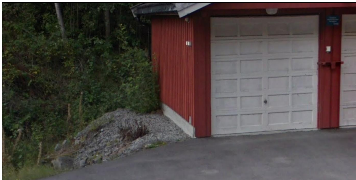
Figur 7 Eksisterende garasjebygg ved Kaggefoss kraftverk langs Kaggefossveien er bygget over Sjulselva. OPI-kanal (50 kV Gravfoss-Kaggefoss) vil etableres over elva på samme måte ved at bekken legges i rør og OPI-kanalen legges over rørene.
