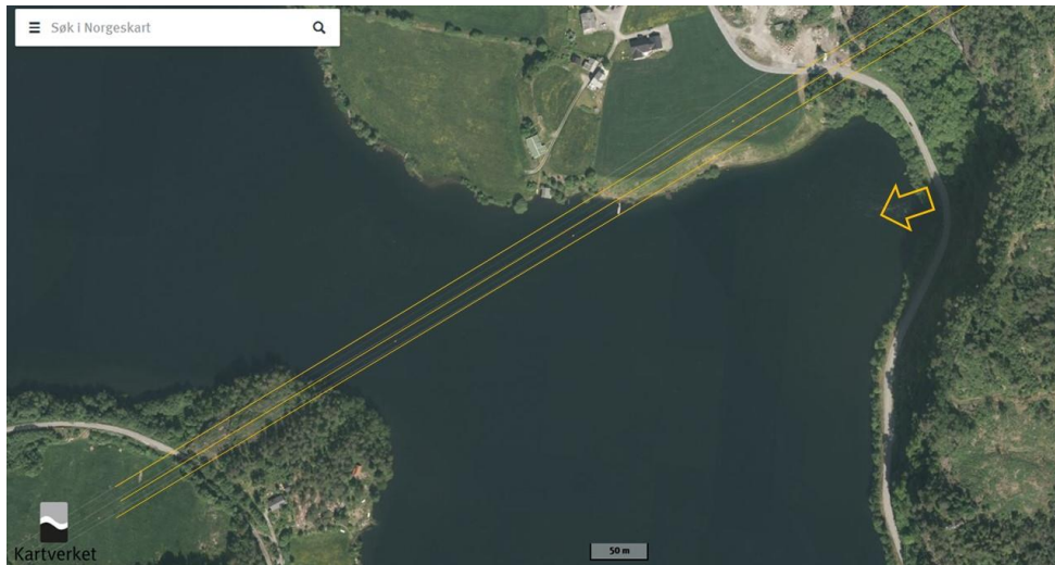
Figur 9. 300 kV kraftlinjen over Evangervannet ca 300 meter vest for utløpstunellen fra Evanger kraftverk. Kraftlinjen Evanger-Samnanger passerer rett over området hvor det ble observert at mye smolt døde i forsøkene i 2015 og 2016. Kraftlinje og kraftverksutløp merket av forfatteren.
