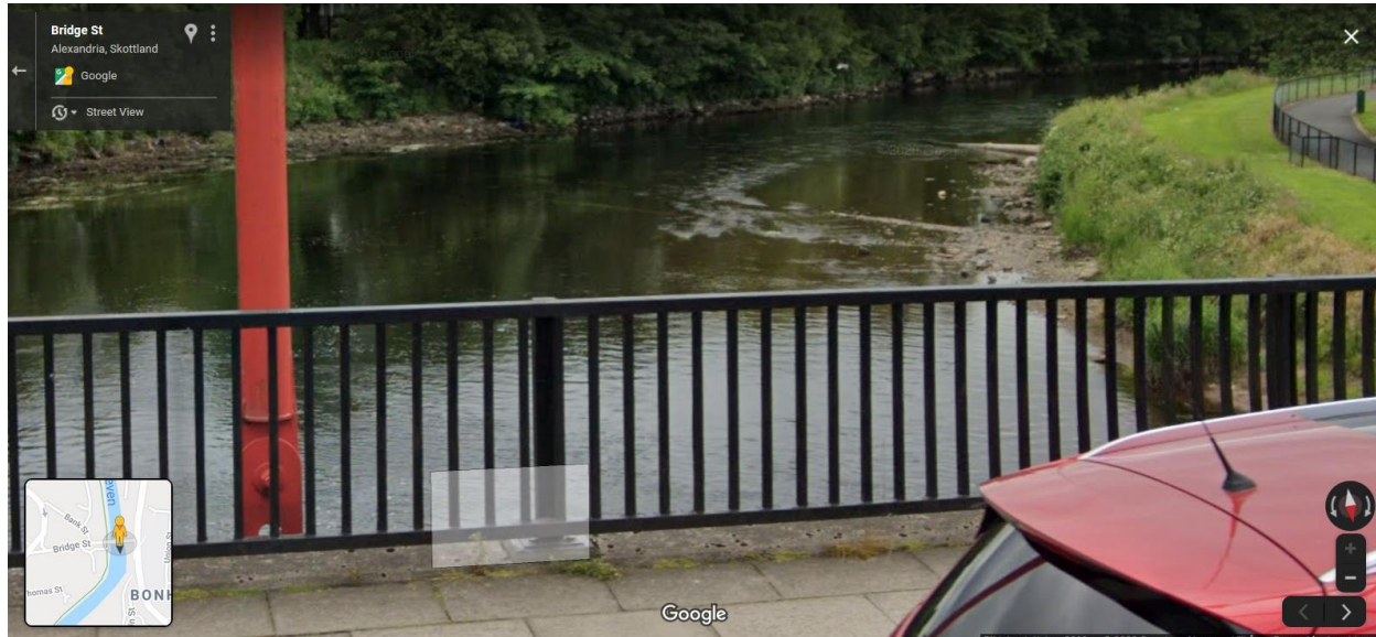
Figur 13. Bonhill Bridge Poll, River Leven, Dunbartonshire, Scotland. De to undervannskablene sees rett over gjerdet ut fra venstre elvebredd. I bakgrunnen et avløpsrør i betong. Fra Google Street View. Kablene sees også godt på satellitt bilde. Bilde tatt ut av JCH for illustrasjon.
