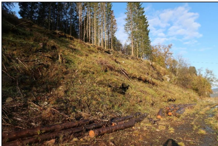
Figur 6. Den vestlige skråningen sett mot nord, helt sør i kartleggingsområdet. Jordskråningen har generell helning rundt 30°, mens mindre framspring er brattere (< 60°). Det er generelt tynne løsmasser over berget.
