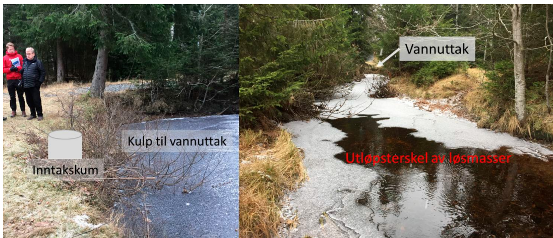
Figur 1. Bildet til venstre vises forslag til plassering av inntakskum ved kulpen. Ca. 26 m nedenfor kulpen ligger utløpsterskelen til kulpen som består av løsmasser av småstein og grus.
