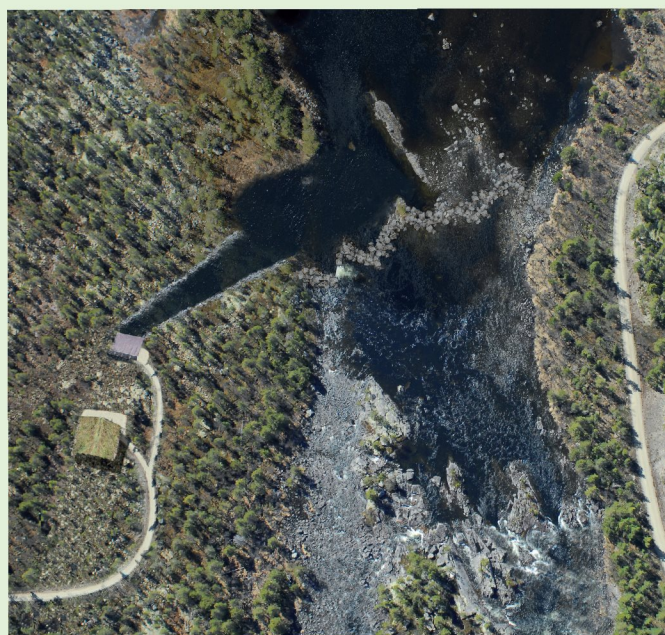
Visualisering av terskel og inntak ved Nedre Svangtjønn
