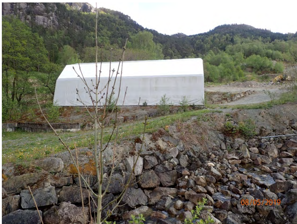
Bilde 12, tatt mot øst, viser området for ny kraftstasjonsbygg som vil komme der plasthallen står i dag
