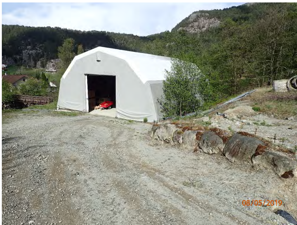
Bilde 13, tatt mot nord nordvest, viser området for den nye kraftstasjonen
