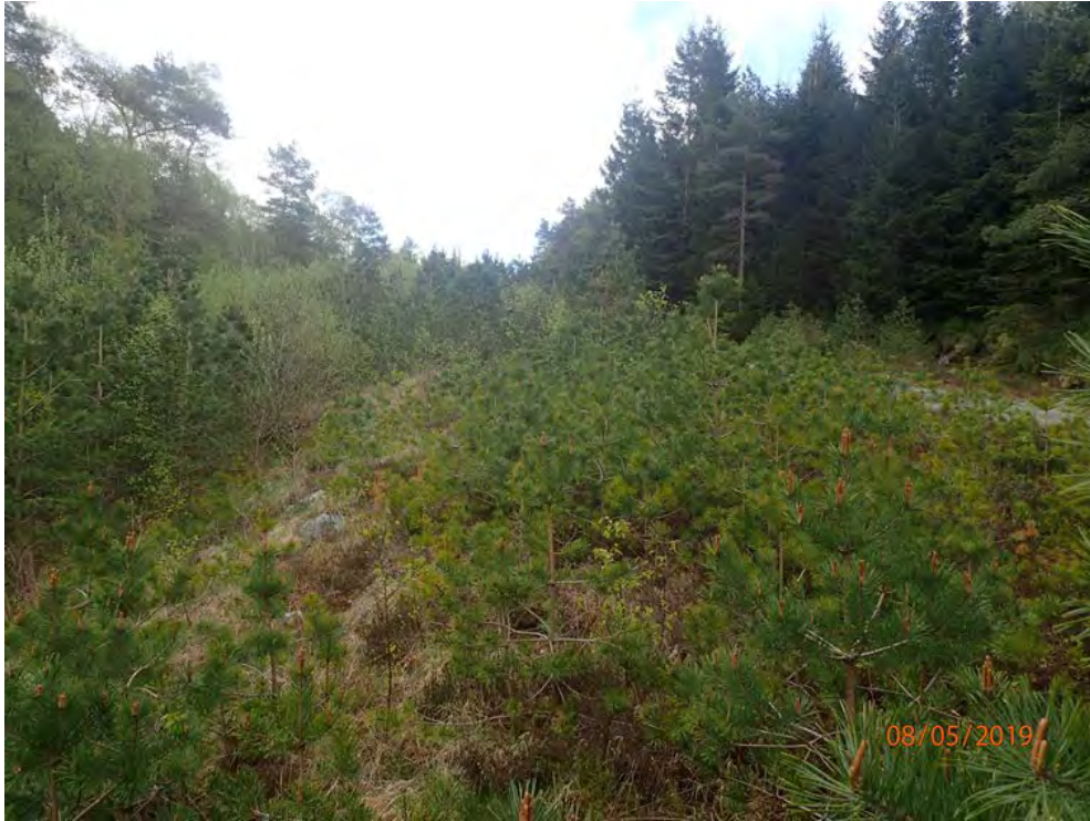
Bilde 10, tatt mot sydøst fra P600 (motsatt retning), viser traseen for det nye trykkrøret ø800 mm mot inntaket
