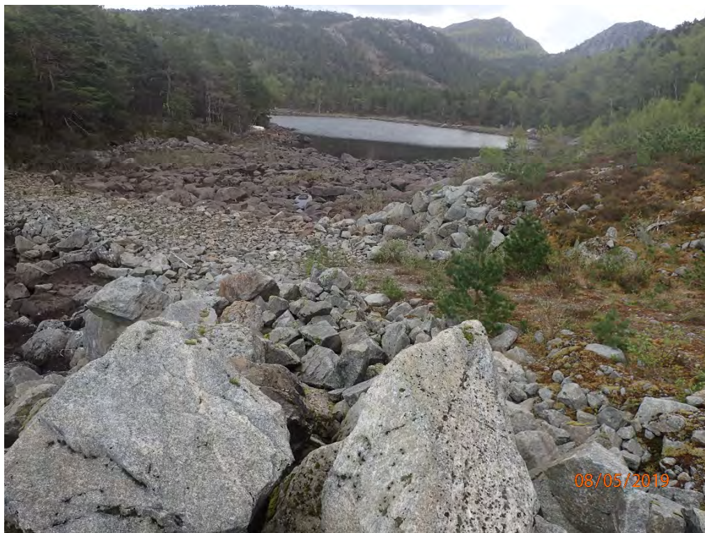
Bilde 6, tatt mot øst, viser dammen som er tenkt plassert med damakse der «veien» over utløpet ligger, men eksakt plassering må bestemmes senere ut fra vurderinger av grunnforhold og omfang (volum) av dammen, Paddevatnet sees i bakgrunnen
