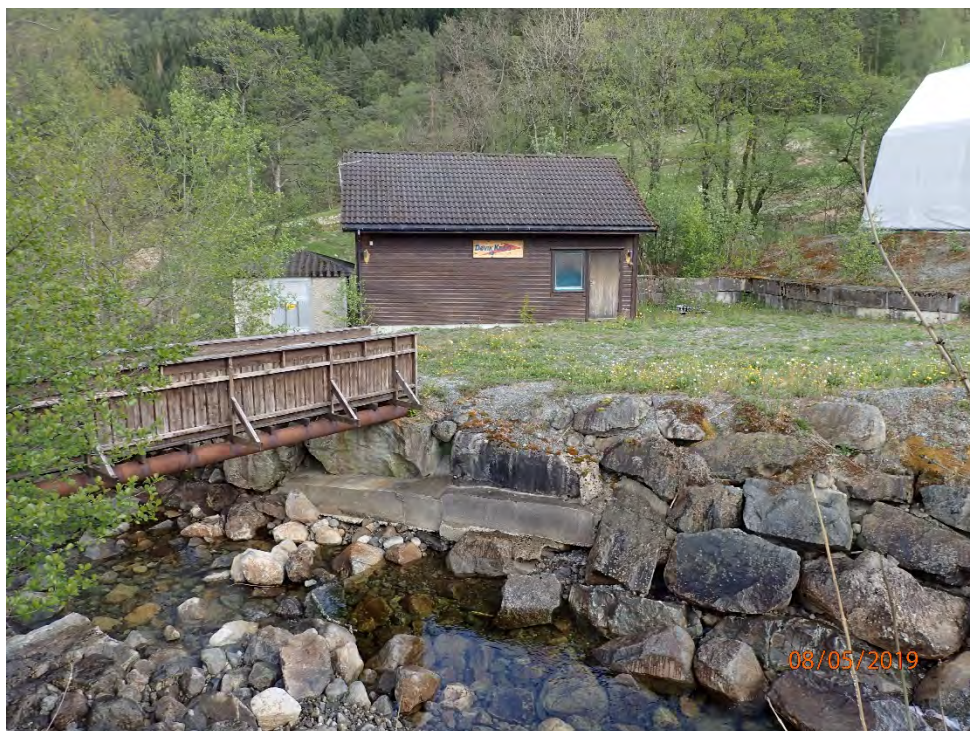
Bilde 11, tatt mot øst, viser eksisterende kraftstasjonsbygg for Døvik Kraft AS. Utløpet fra turbinen renner ut i Paddevassåna (som renner bak kraftstasjonen), Døvikåna sees nederst i bildet (i forgrunnen)
