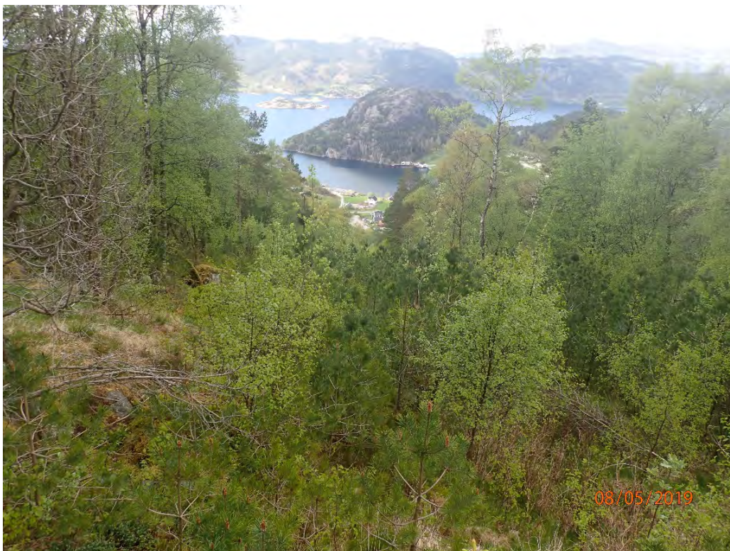
Bilde 9, tatt nordover fra P600 fra veien mot kraftstasjonen, viser traseen for det nye trykkrøret ø800 mm, og her ligger også eksisterende trykkrør ø400 til Døvik Kraft AS nedgravd
