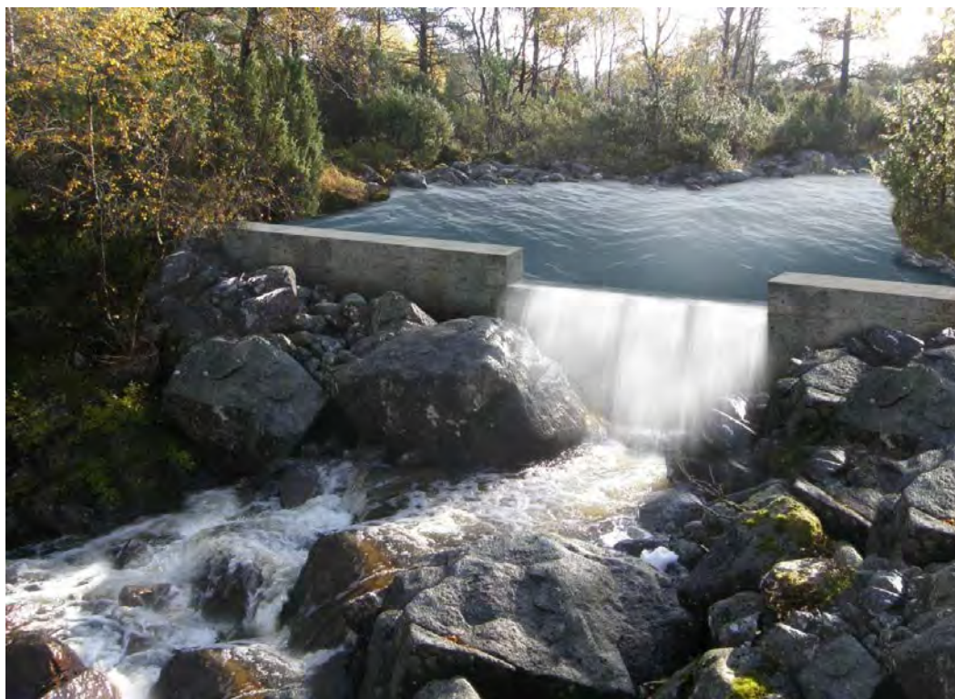
Bilde 2, tatt mot syd, viser eksempel på plastøpt dam og inntak, overføringsledningen ø630 mm PE vil komme på venstre side i bildet
