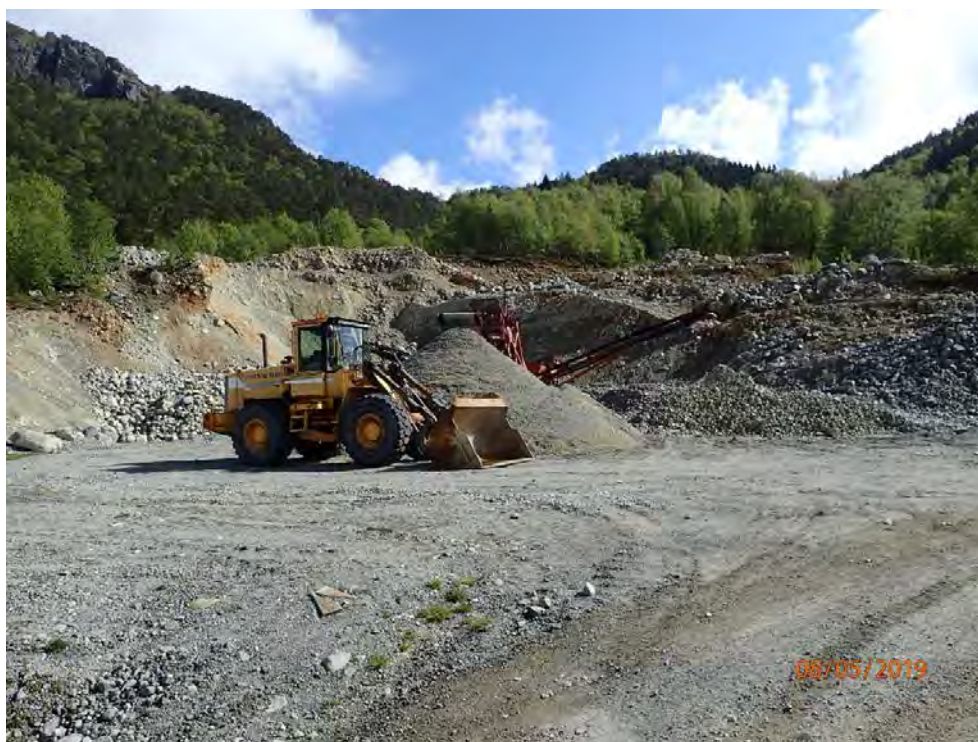
Bilde 14, tatt mot syd sydvest, viser massetaket like over kraftstasjonsområdet
