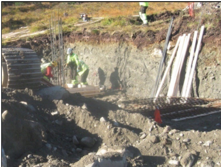
Figur 18 Eksempel mastefundament i løsmasser.
