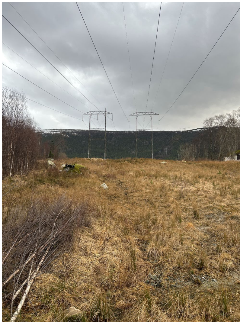
Figur 11 Eksisterende 300 kV forbindelse mellom master 43 og inn mot Husnes transformatorstasjon skal rives.
