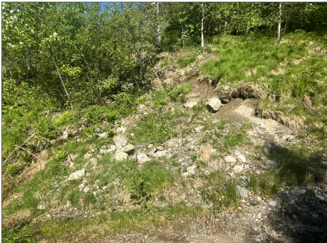
Bilde 5 Infopunkt 1057. Bilde tatt mot nord/nordvest.
