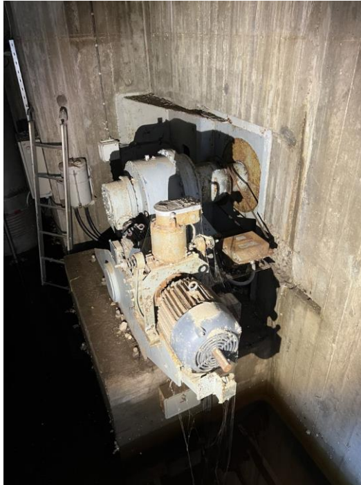
Lukespill, med motorer som har vært dykket.
