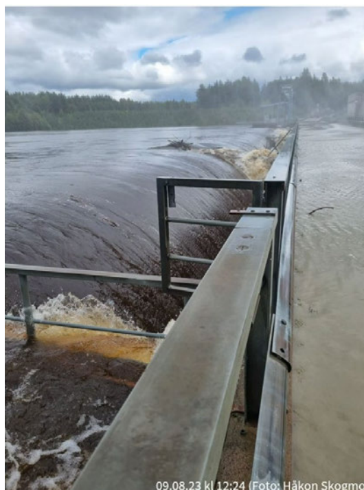
Bilde 10 Overtopping av flomlukene kl. 12:24 (Foto Håkon Skogmo / Kilde NVE)
