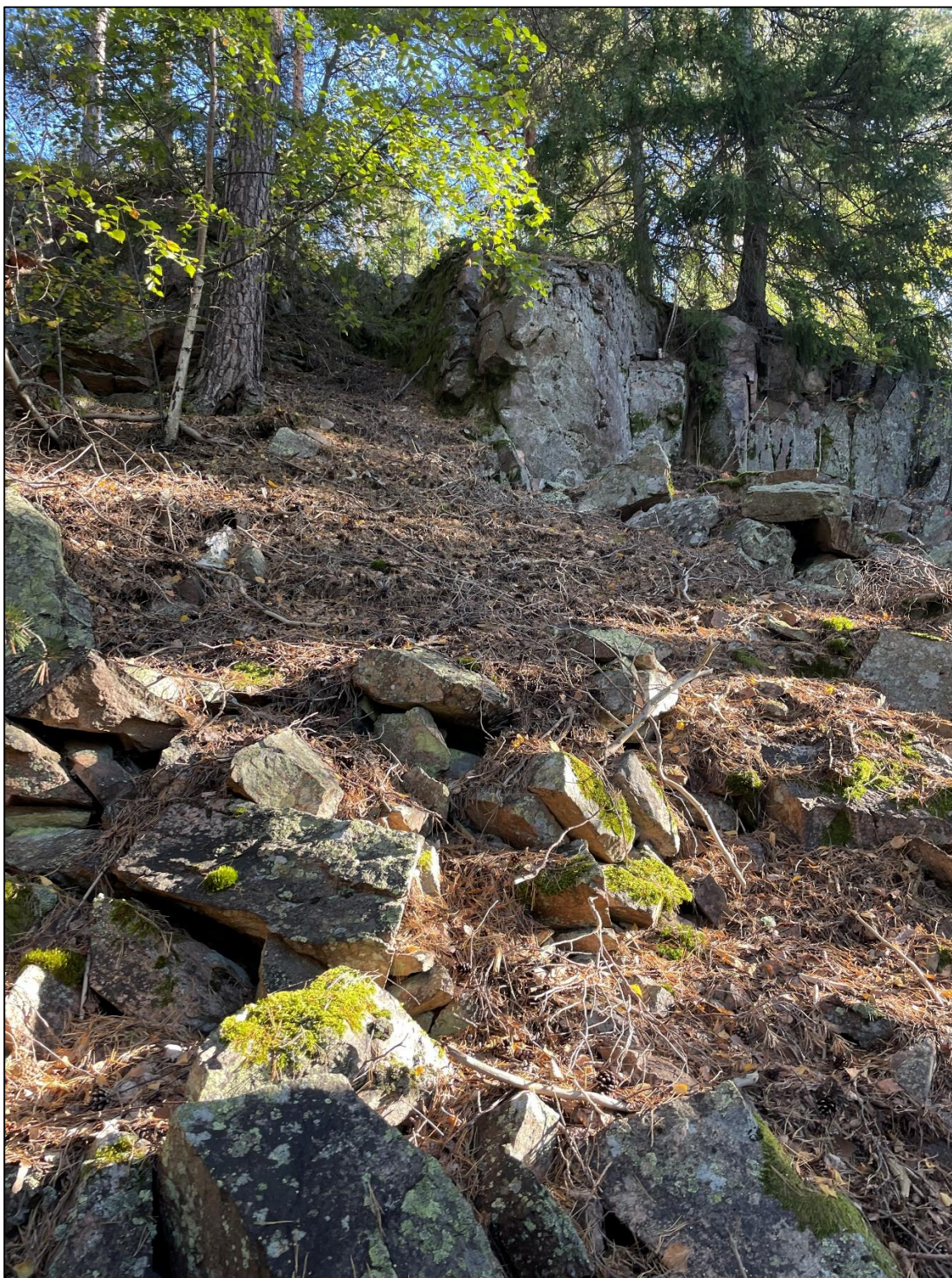
Figur 4: Bilde av en av de mindre bergskrentene i kartleggingsområdet, som viser godt oppsprukket berg med potensiale for bl.a. rotsprengning, noe blokkutfall og en del stedeagne forvittringsblokker overlagret med et tynt humusdekke.
