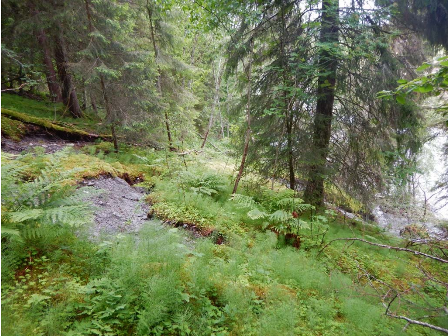
Figur 13: Glidning 2 lengre ned i skråningen 11.07.2017. (Foto: NVE/gbh)
