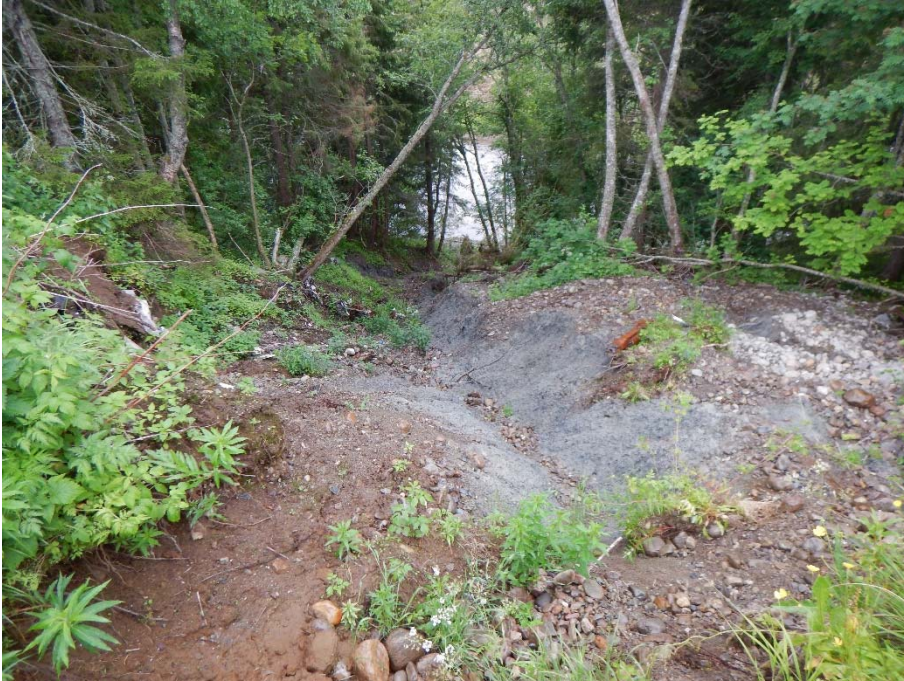
Figur 11: Glidning 1 som starter i toppen av skråningen 11.07.2017. (Foto: NVE/gbh)
