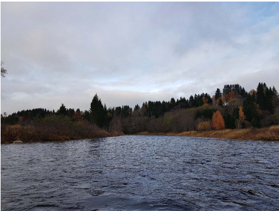
Figur 20: Sideløpet i Sanddøla ved Formo. Formøya til venstre og begynnelsen av skråningen som skal sikres til venstre. (Foto: NVE/phh)
