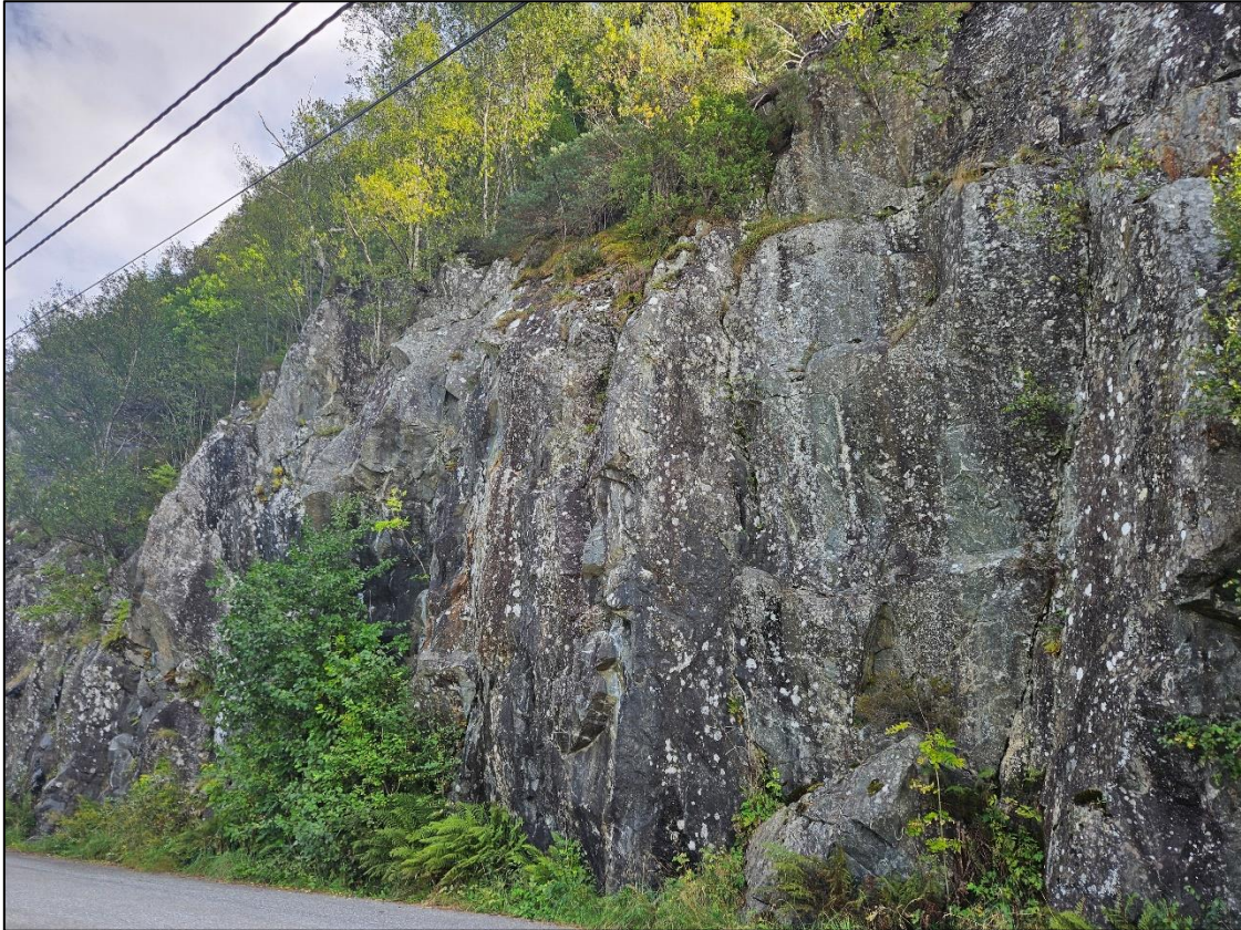
Figur 8. Bergskrent/skjæring på oppsiden av veien.
