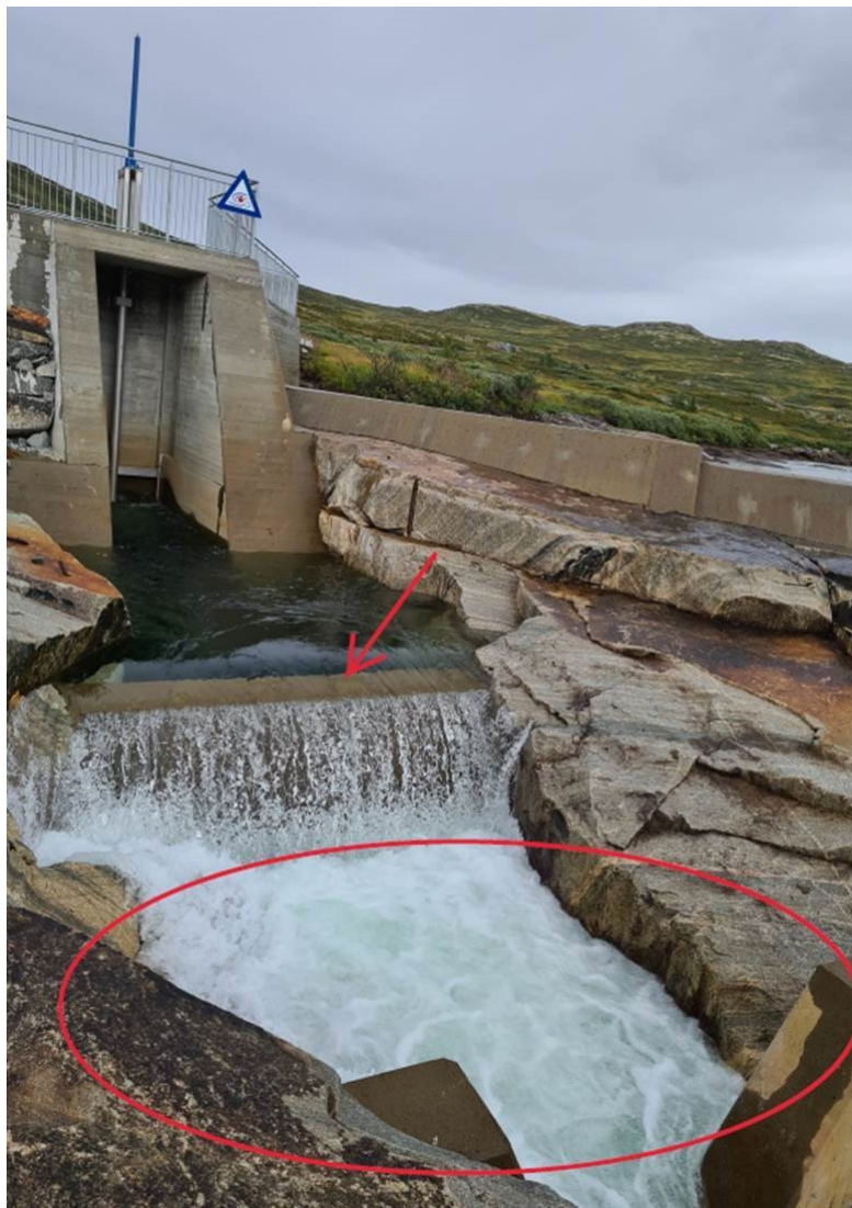
Figur 1. Foto av avløpskanalen. Målekulpen markert med rød sirkel. Terskel som utbedres markert med rød pil.
