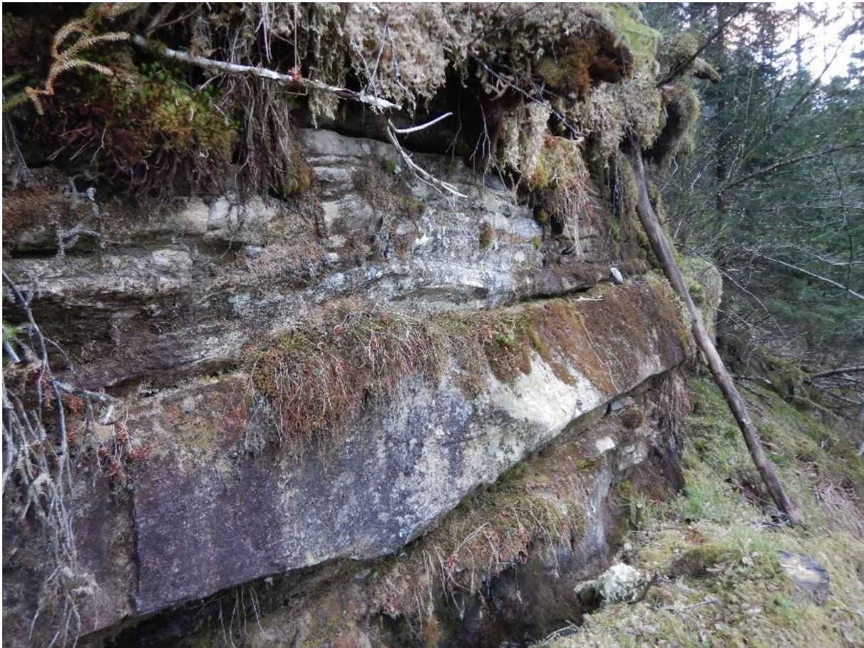
Figur 5: Det er ikke oppstikkende bergmasse i nærskråningen. Dette partiet like utafor påvirkningsområdet framstår som lite oppsprukket. Det er ingen tegn til fersk steinsprangaktivitet. Noen få eldre forvitrede blokker ligger nedetter skråningen. Bildet er tatt mot vest. Denne bergskrenten kan ses helt til høyre i den gule ellipsen i Figur 2.
