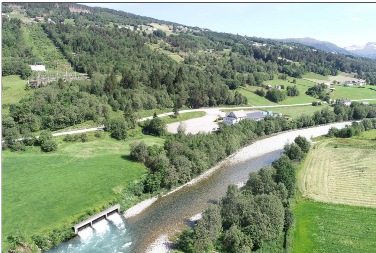
Figur 3-4: Illustrasjon av kulvert ut mot Storelva. Terreng vil føres tilbake over kulvert, slik at dette arealet i fremtiden vil fremstå med ubetydelige visuelle endringer i forhold til dagens situasjon.
