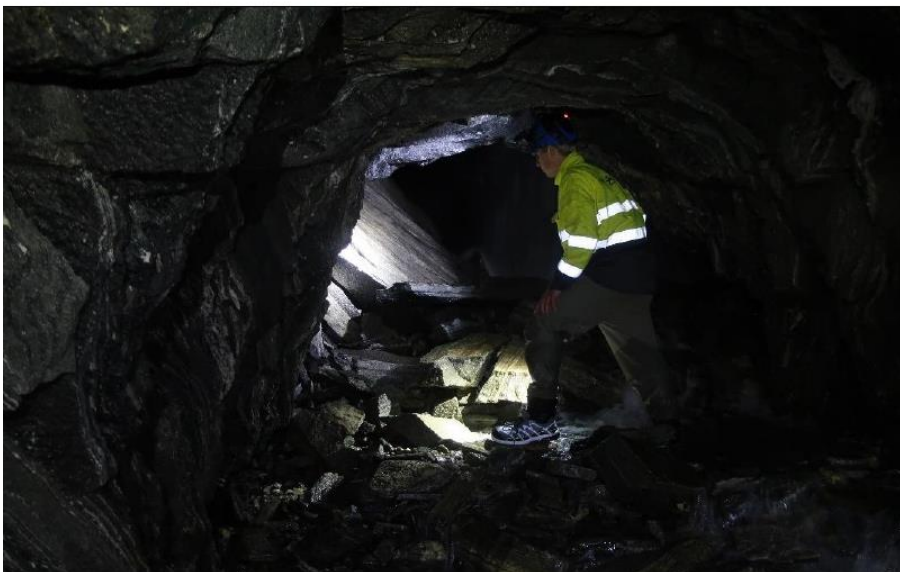
P195-200: Rasmasser ved bekkeinntak. Person for skala
