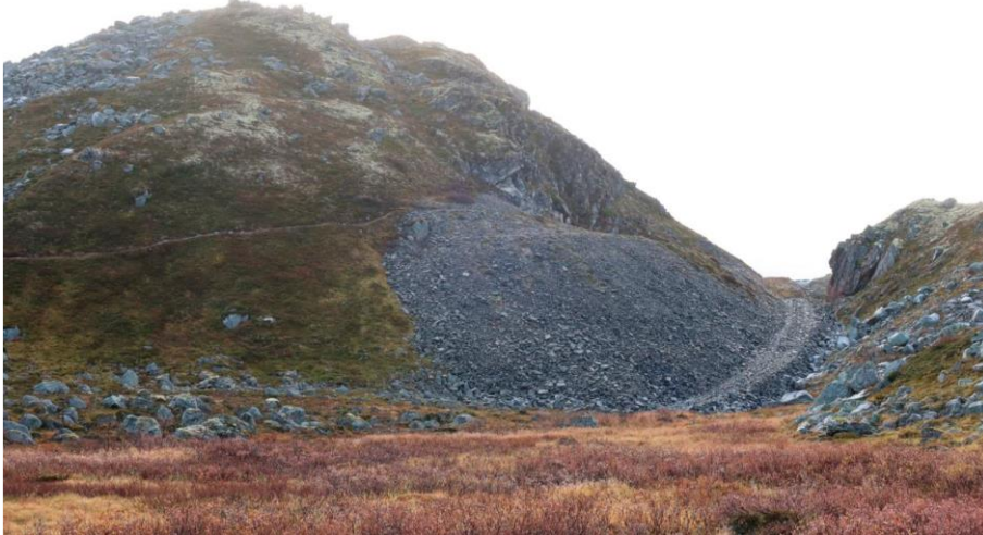
Bilde av deponiet ved Grønvollsteinen.
