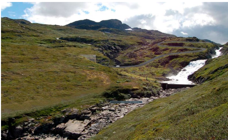
Figur 6. Fotomontasje av kraftstasjon og massedeponi (planendringssøknad s. 11).
