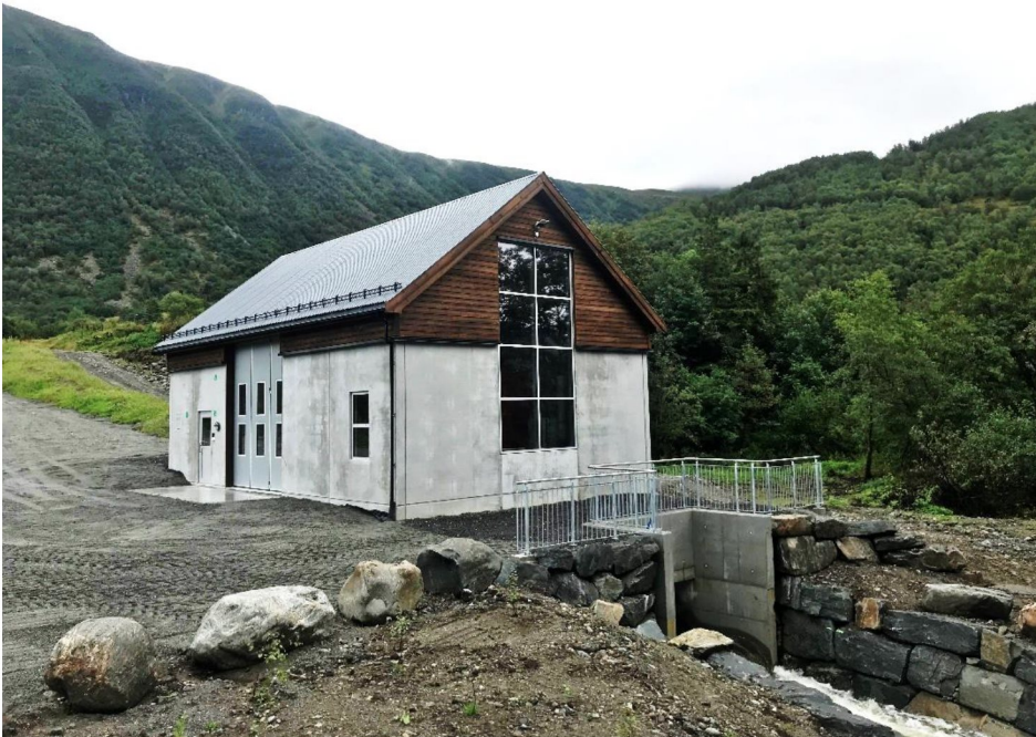
Figur 17: Typisk kraftstasjonsbygning. (Bildet fra Røfsdalselva kraftverk. Foto: NGK)
