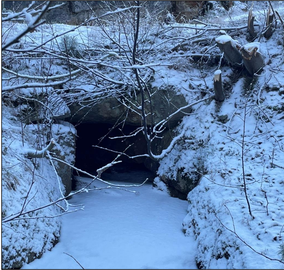
Figur 26: Gjennomføring under veg i nordvestleg del av kartleggingsområdet.
