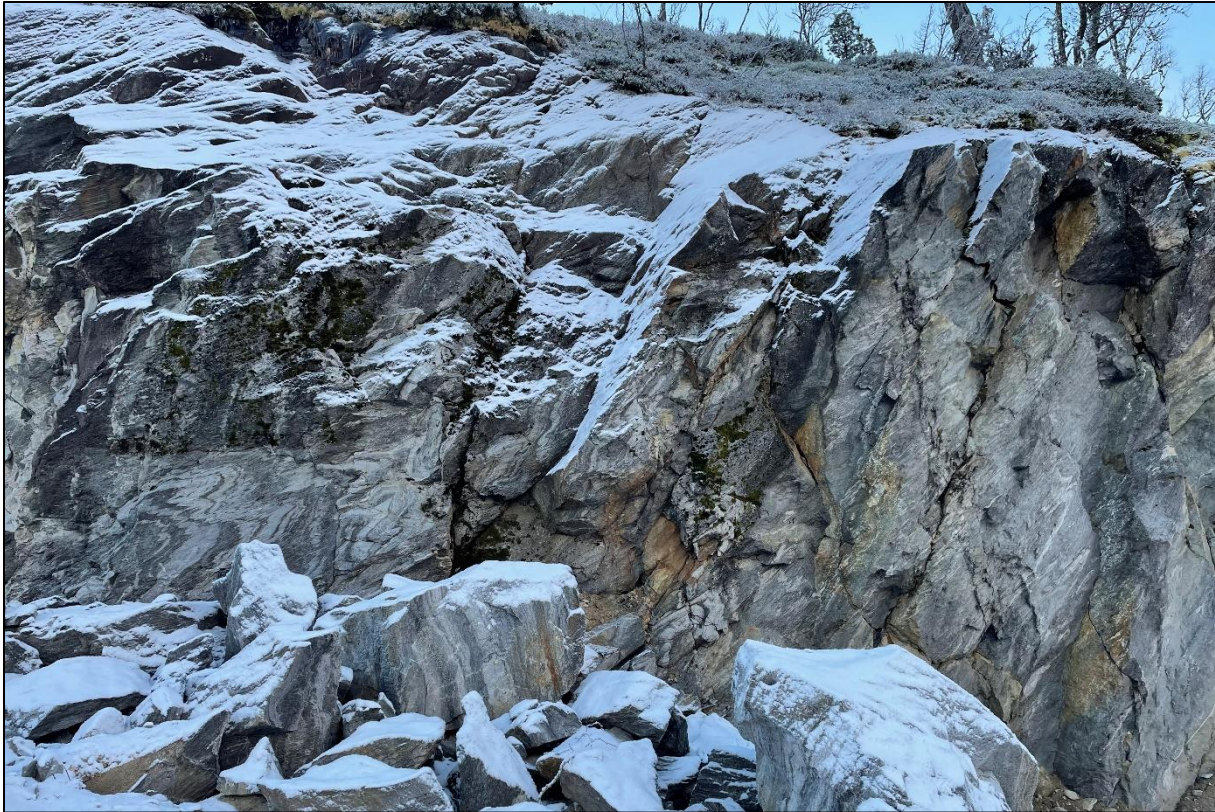
Figur 28: Skjering i midtre delar av kartlagd område. Foldestrukturar i gneis kan observerast til venstre i bilete. Infopunkt 5.
