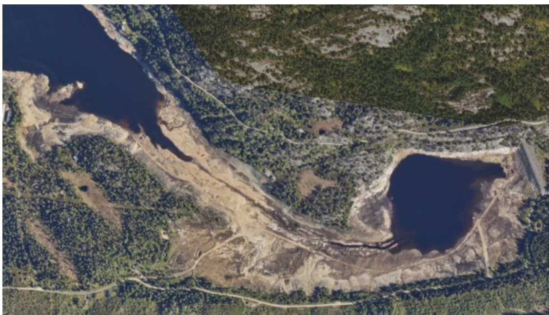
Figur 21. Flyfoto fra helt sør i Sundsbarmvatn (kilde: Norgebilder.no), der øverste fra 2021 viser vannstand litt under HRV, mens nederste fra 2022 viser vannstand nær selvpålagt minimum sommervannstand (kote 598). I reguleringssonen på sørsiden sees veier ned til utsettingssteder for båter.
