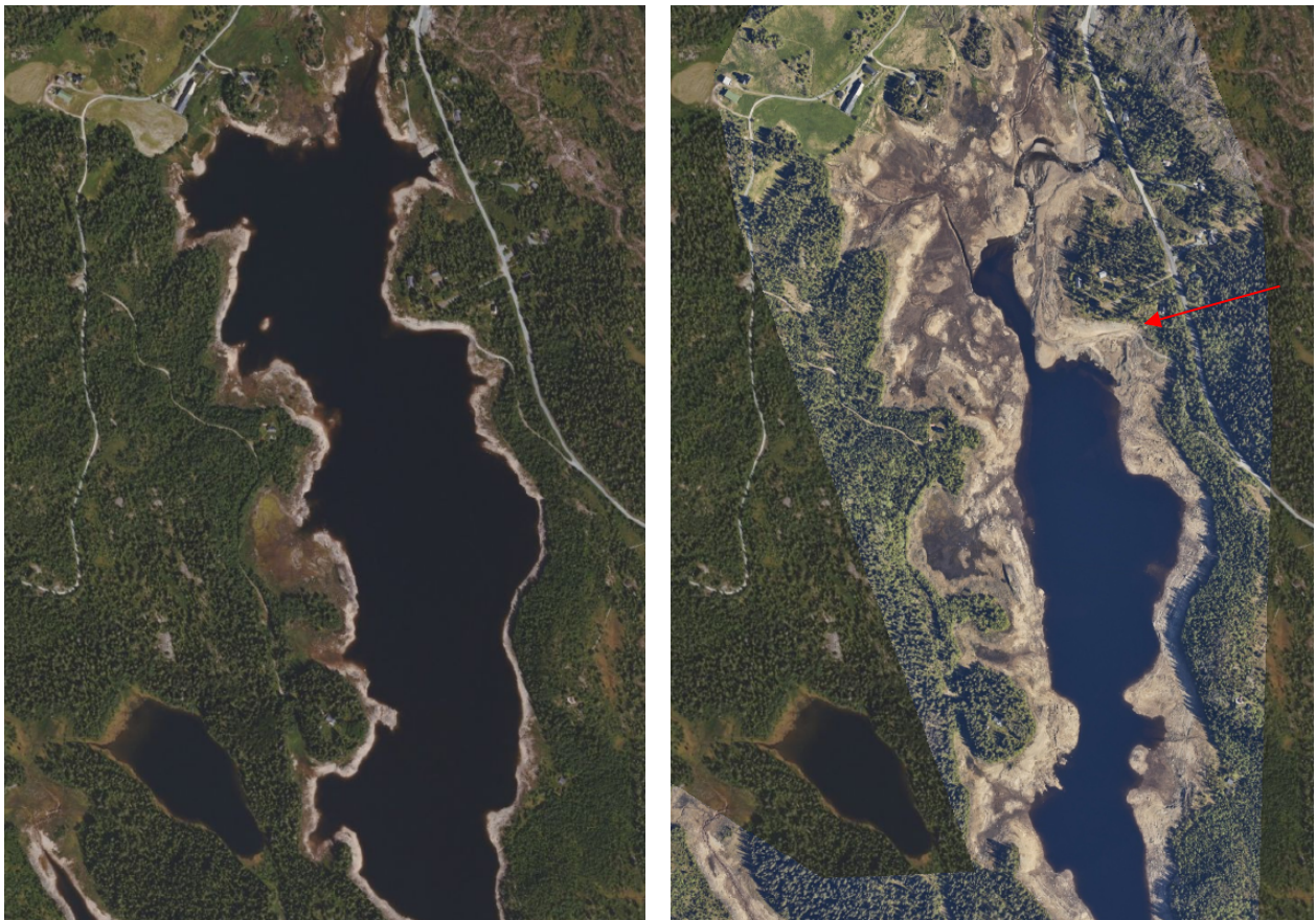
Figur 22. Flyfoto fra helt nord i Sundsbarmvatn (kilde: Norgebilder.no). Foto til venstre fra 2021 viser vannstand litt under HRV. Foto til høyre fra 2022 viser vannstand nær selvpålagt minimum sommervannstand (kote 598). På østsiden ses vei ned i reguleringssonen til utsettingssted for båter.
