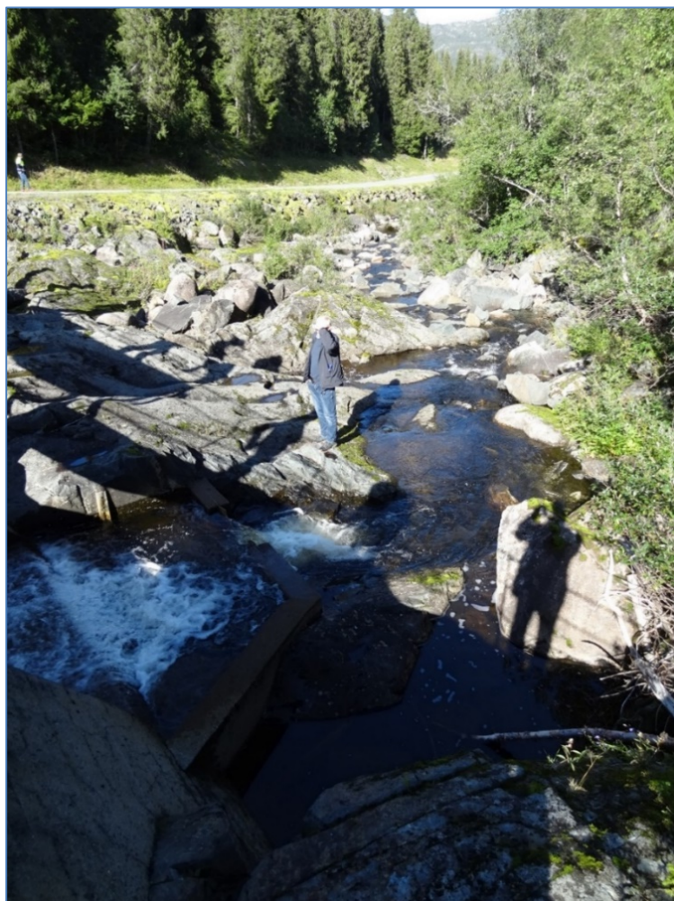
Figur 9. Fotoet viser minstevannføring på 0,050 m 3 /s fra inntaket i Grovenåi (foto fra NVEs befarings 3.9.2019)
