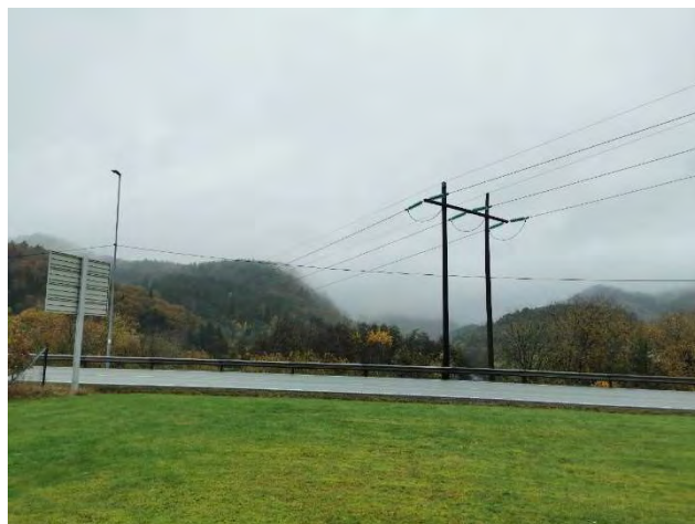
Figur 3-57 Bilde tatt i retning av eksisterende linjer. Foto: Norconsult.
