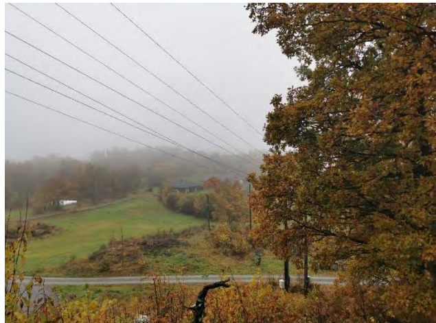
Figur 3-50 Bilde av dagens ledninger. Foto: Norconsult.
