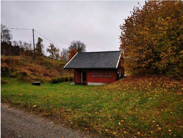
Figur 3-70 Grå SEFRAK bygning (1032-0003-096) er kraftig endret. Foto: Norconsult.
