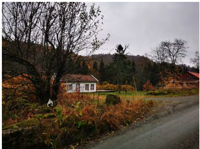
Figur 3-73 Nedre Skårdal (1032-0003-101). Deler av Nedre Skårdal står til nedfalls. Foto: Norconsult.
