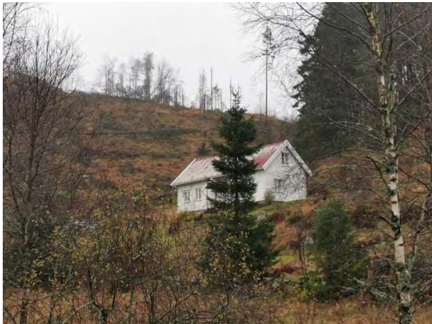
Figur 3-90 Våningshus på Vatland (1037-0016-026). Huset er noe endret fra SEFRAK registrering, med overbygget inngangsparti. Foto: Norconsult.
