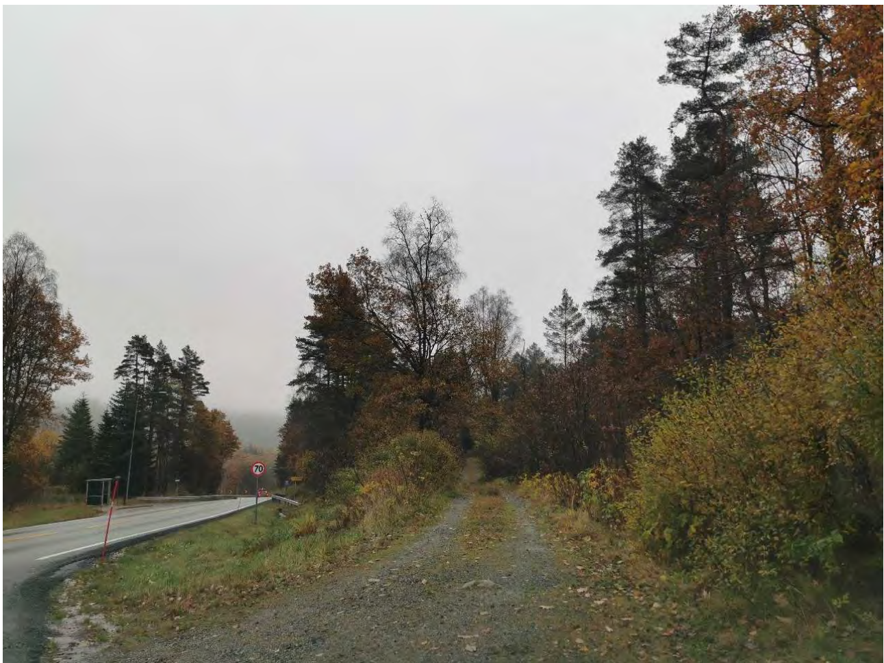
Figur 3-35 Postveien som kjørevei. Bilde tatt i retning Lene mot sørøst. Foto: Norconsult.
