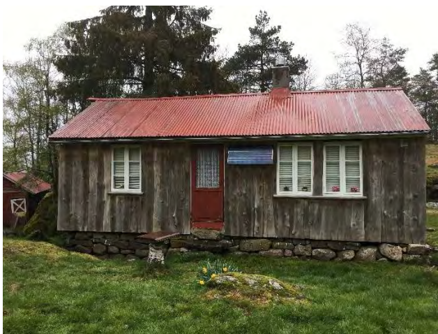
Figur 3-11 Foto av stående bygning på Banken. Foto: Hege Andreassen, Vest-Agder fylkeskommune - Fylkeskonservatoren.
