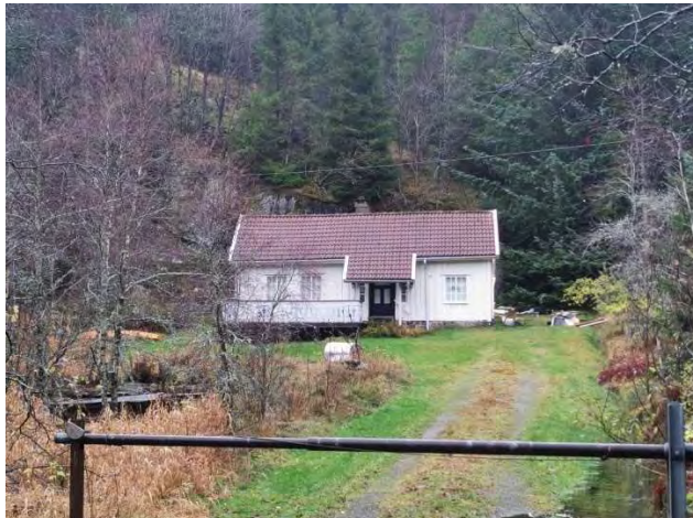
Figur 3-91 Våningshus på gården Vatland (1037-0016-023). Huset er endret med overbygget inngangsparti og terrasse etter SEFRAK registreringene. Foto: Norconsult.
