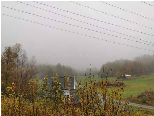
Figur 3-49 Dagens ledninger gjennom delområdet. Foto: Norconsult.
