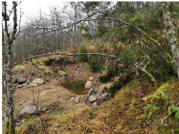
Figur 3-67 Bilde tatt ved deler av postveien som ridevei ved Birkeland i Dragedalen. Veien er delvis skadet av masseuttak. Foto: Norconsult.
