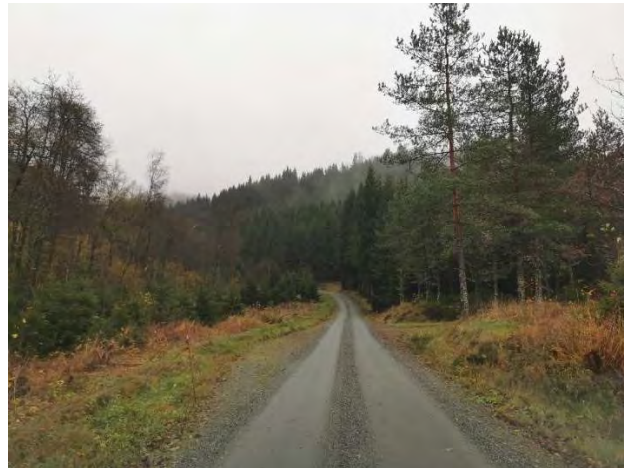
Figur 3-88 Postveien som kjørevei. Idag brukt som fylkesvei som følger igjennom Dragedalen. Foto: Norconsult.
