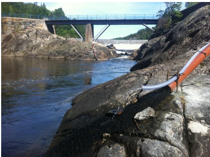
Figur 7-2. Eksempel på oppvandringstiltak for oppvandrende ål, her med lokkevann som skal imitere vannsig i siden av fossen der ålen gjerne vandrer opp nattetid (Foto: Håkon Gregersen, Norconsult AS).
