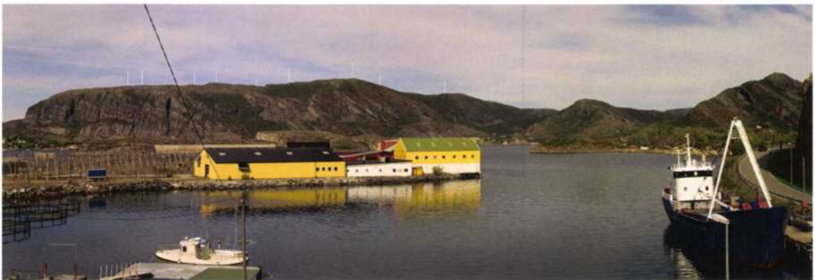
Figur 14 Harbaksfjellet vindpark sett fra Stokksund. Møllene på Svanaheia og innenfor markerer seg godt i omgivelsene, men avstanden er også såpass stor at konflikten vurderes som moderat. Større bilde finnes som vedlegg.
