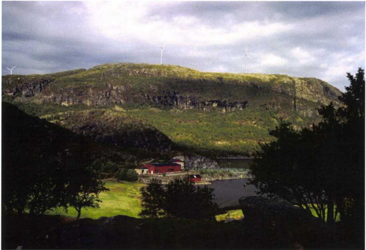
Figur 13 Harbaksfjellet vindpark sett fra Sunnskjørin. Særlig møllene på Raudhammaren får en dominerende og iøynefallende plassering sett fra bebyggelsen. Større bilde finnes som vedlegg.
