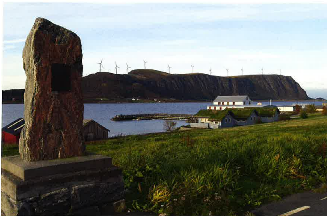
Figur 20 Vindparken på Haramsfjellet sett fra Longva på Flemsøy
