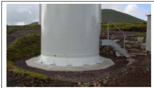
Figur 12: Eksempel på turbinfundament, forankret i fjell
