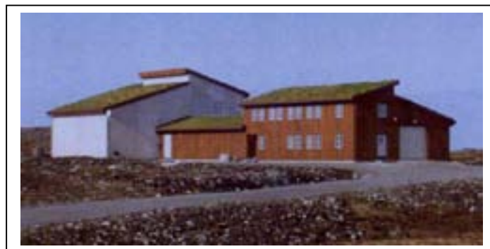
Figur 16: Eksempel på utførelse av transformatorstasjon og servicebygg (Smøla vindkraftverk/Statkraft Energi)
