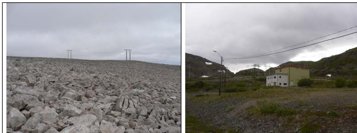
Figur 43 a og b. Eksisterende kraftlinje (a) mot transformatorstasjonen i Kobbkroken (b). Foto: Gunnar Henriksen
