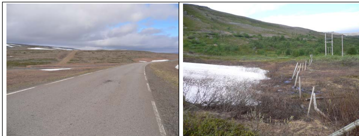
Figur 6.34 a og b. Eksisterende gjerde krysser hovedveien (A), den gamle veien kan ses i venstre del av bildet A. Samme gjerdet kan sees i bilde (B) hvor det kommer ned ved avkjørselen til flyplassen i Båtsfjord. Den gamle veien vises oppe i lia til venstre i bildet. Foto: Gunnar Henriksen.
