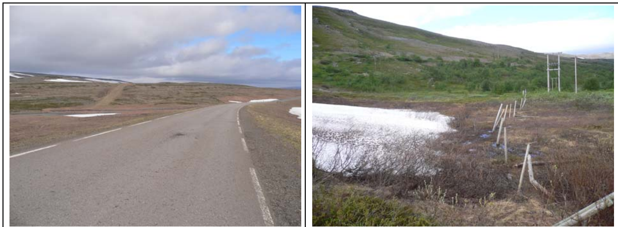
Figur 6.16 a og b. Eksisterende gjerde krysser hovedveien (A), den gamle veien kan ses i venstre del av bildet A. Samme gjerdet kan sees i bilde (B) hvor det kommer ned ved avkjørselen til flyplassen i Båtsfjord. Den gamle veien vises oppe i lia til venstre i bildet. Foto: Gunnar Henriksen.
