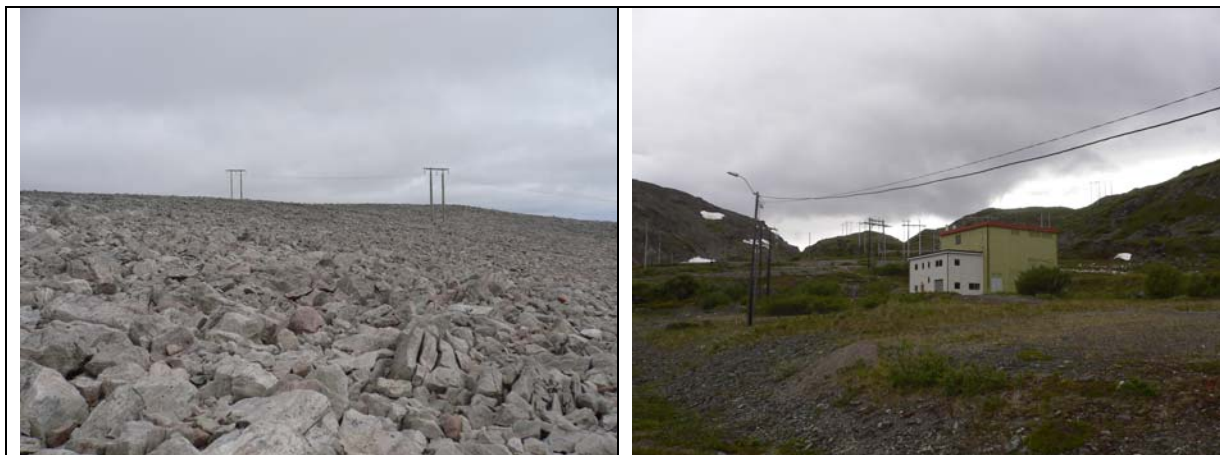
Figur 4 a og b. Eksisterende kraftlinje (a) mot transformatorstasjonen i Kobbkroken (b). Foto: Gunnar Henriksen
