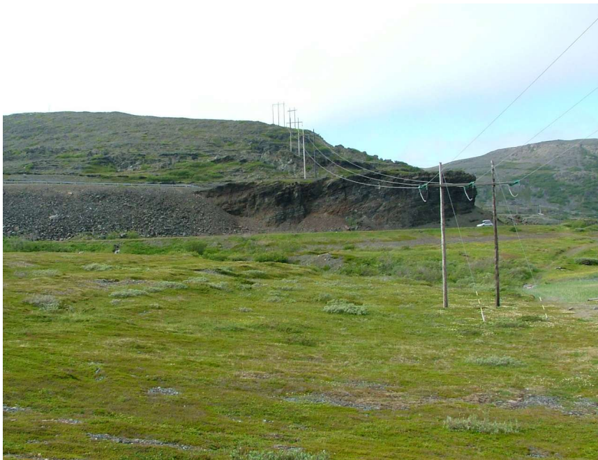
Illustrasjon 3: 66 kV linje på nedsiden av veien ved Kobbkroken. Flere kulturminner ligger i strandvollen på midten av bildet.
