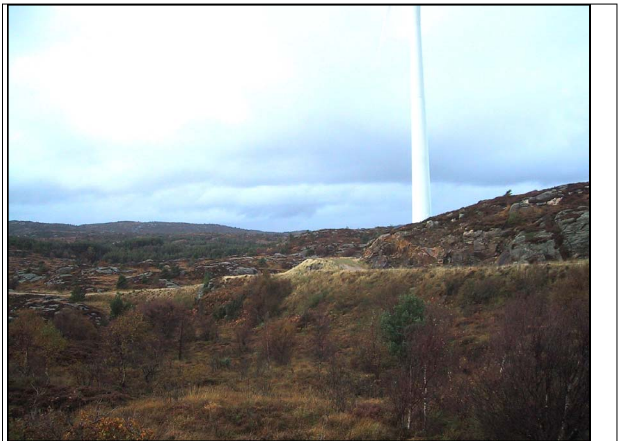
Figur 4.3: Resultat av revegetering av veiskråninger ved Fjeldskår vindmøllepark, Lindesnes.
