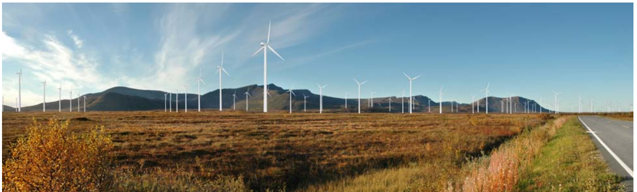
Figur 8.2.5.8 Fotopunkt Ramså, alternativ A; 80 stk turbiner à 2,5 MW Foto: Ingvild Holann, Montasje: Intercon I/S
