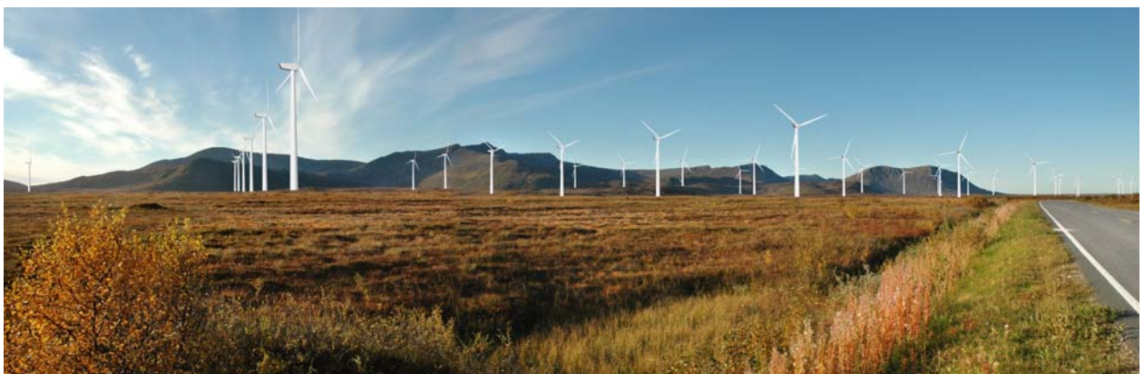
Figur 8.2.5.7 Fotopunkt Ramså, alternativ B; 40 stk turbiner à 5 MW Foto: Ingvild Holann, Montasje: Intercon I/S
