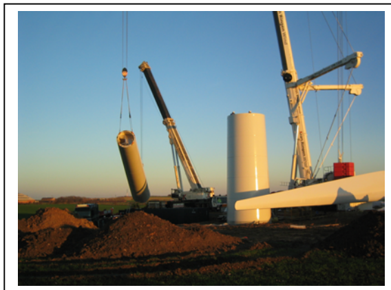
Typisk riggplass-situasjon, 2 MW vindmølle (Foto: Steinar S. Helland)
